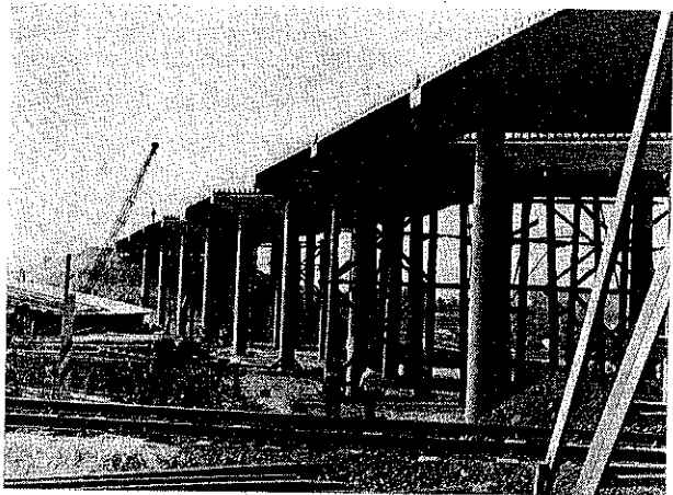
2. kép. Fordított T keresztmetszetű előfeszített tartók beemelése (szerző felvétele)
