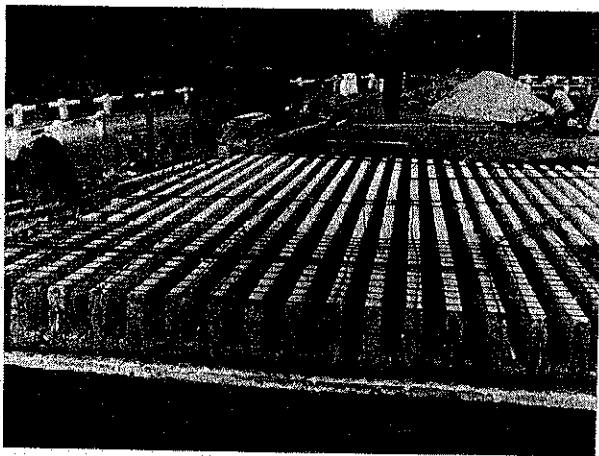
1. kép. Fordított T keresztmetszetű előfeszített tartók beszerelése (szerző felvétele)
