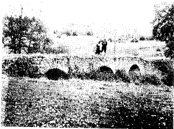
4. kép. Három nyílású boltozott híd Aggteleknél (épült 1820-ban)
