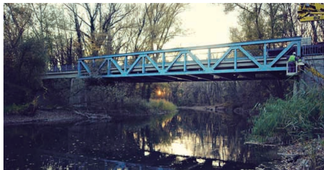
6. ábra: A feketeerdei Mosoni-Duna híd
