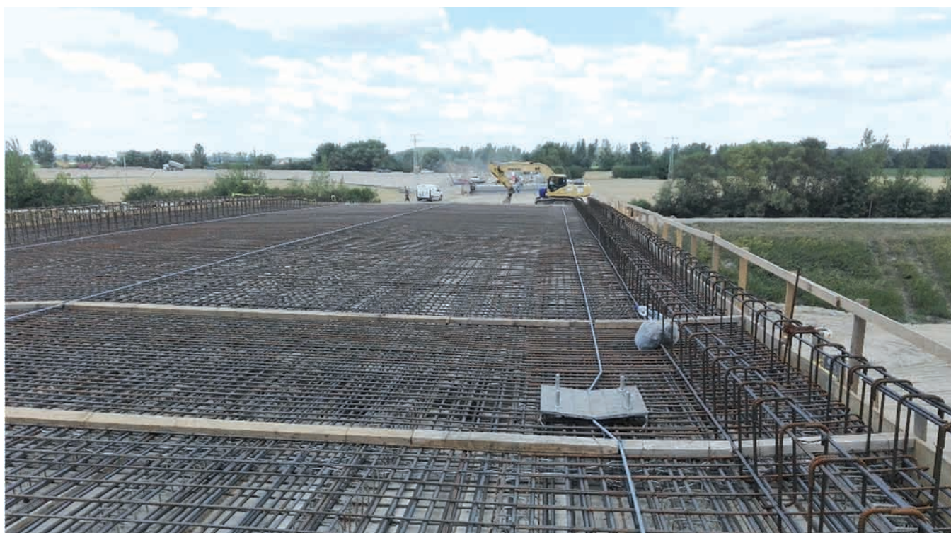
51. ábra: Elkészült vasalás
