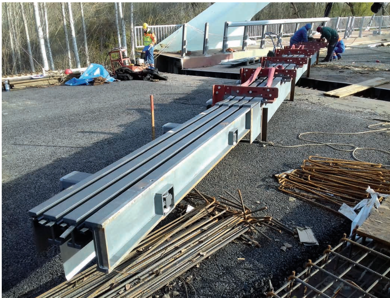
136. ábra: A 3-as pillér dilatációs szerkezete
