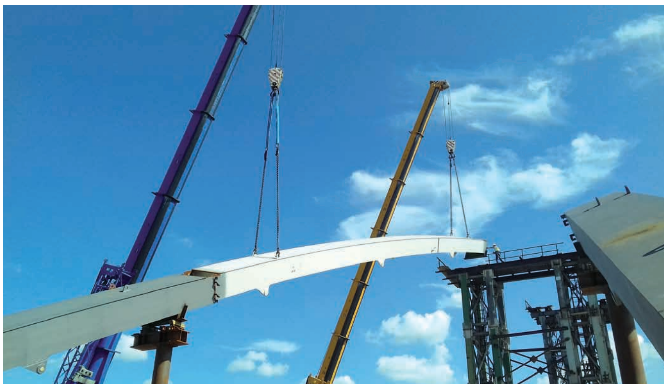
86. ábra: Párosított ívelemek beemelése
