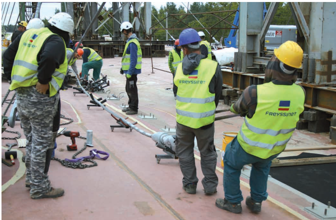
93. ábra: Kábelek kitekerése kiskocsikon
