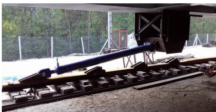
113. ábra: Munkahenger és a tolókonzol
