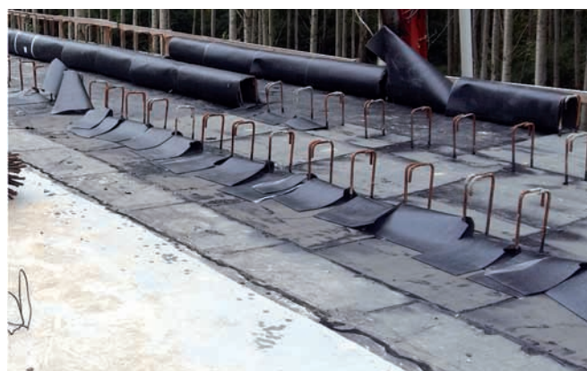
153. ábra: Az ártéri híd bitumenes lemezszigetelése
