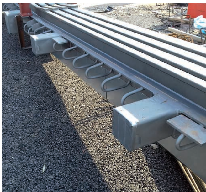
133. ábra: Dilatációs szerkezet betonnal együtt dolgozó része
