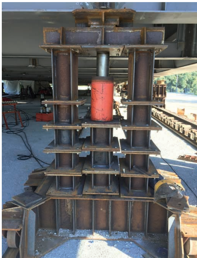
63. ábra: Hidraulikus sajtó emelés ideje alatt
