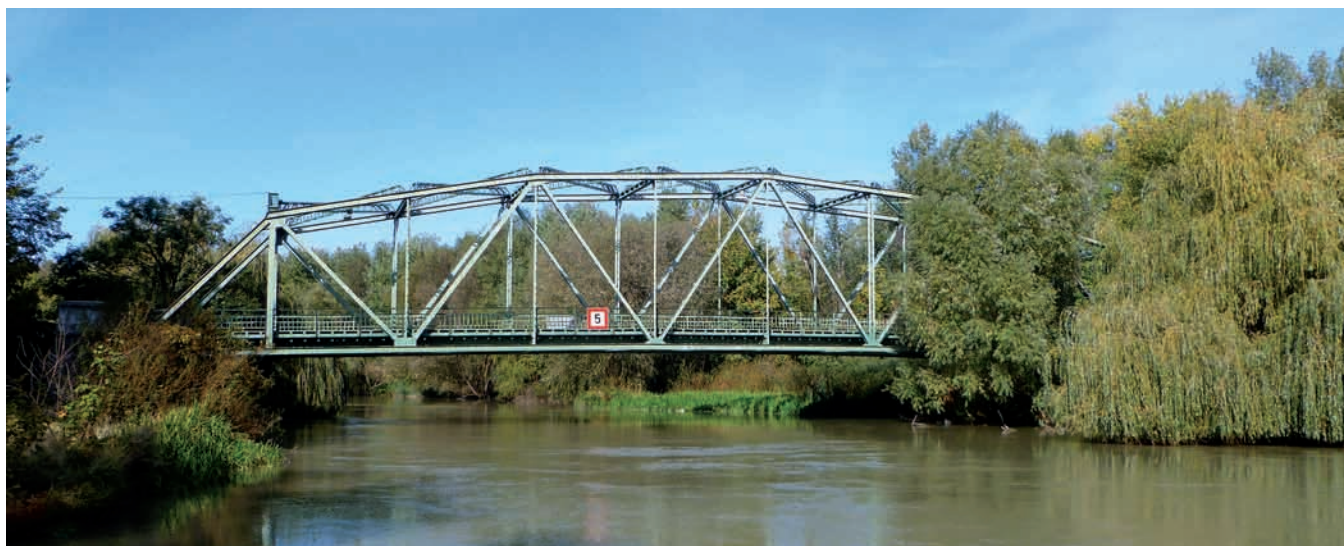
8. ábra: Máriakálnok, Mosoni-Duna-híd [6]
