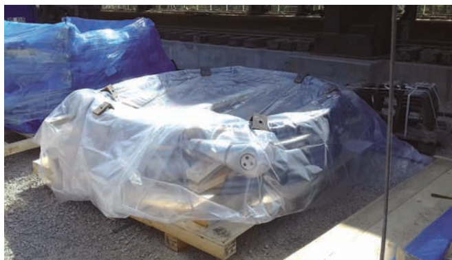
91. ábra: Függesztőkábelek ideiglenes tárolása
