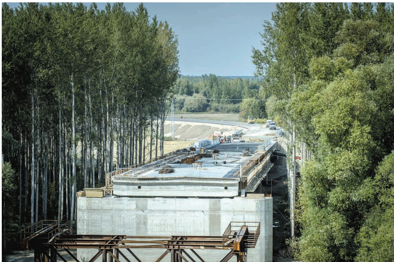
48. ábra: A bal ártéri hídszerkezet szigetelésének készítése
