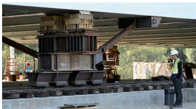
120. ábra: Csúszkakocsi tolás közben
