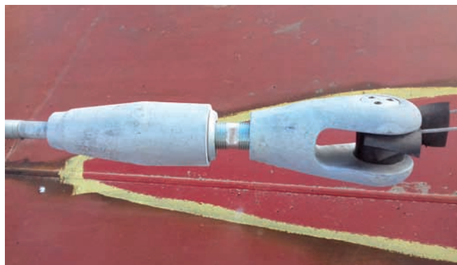
95. ábra: Függesztőkábel alsó villás kialakítása
