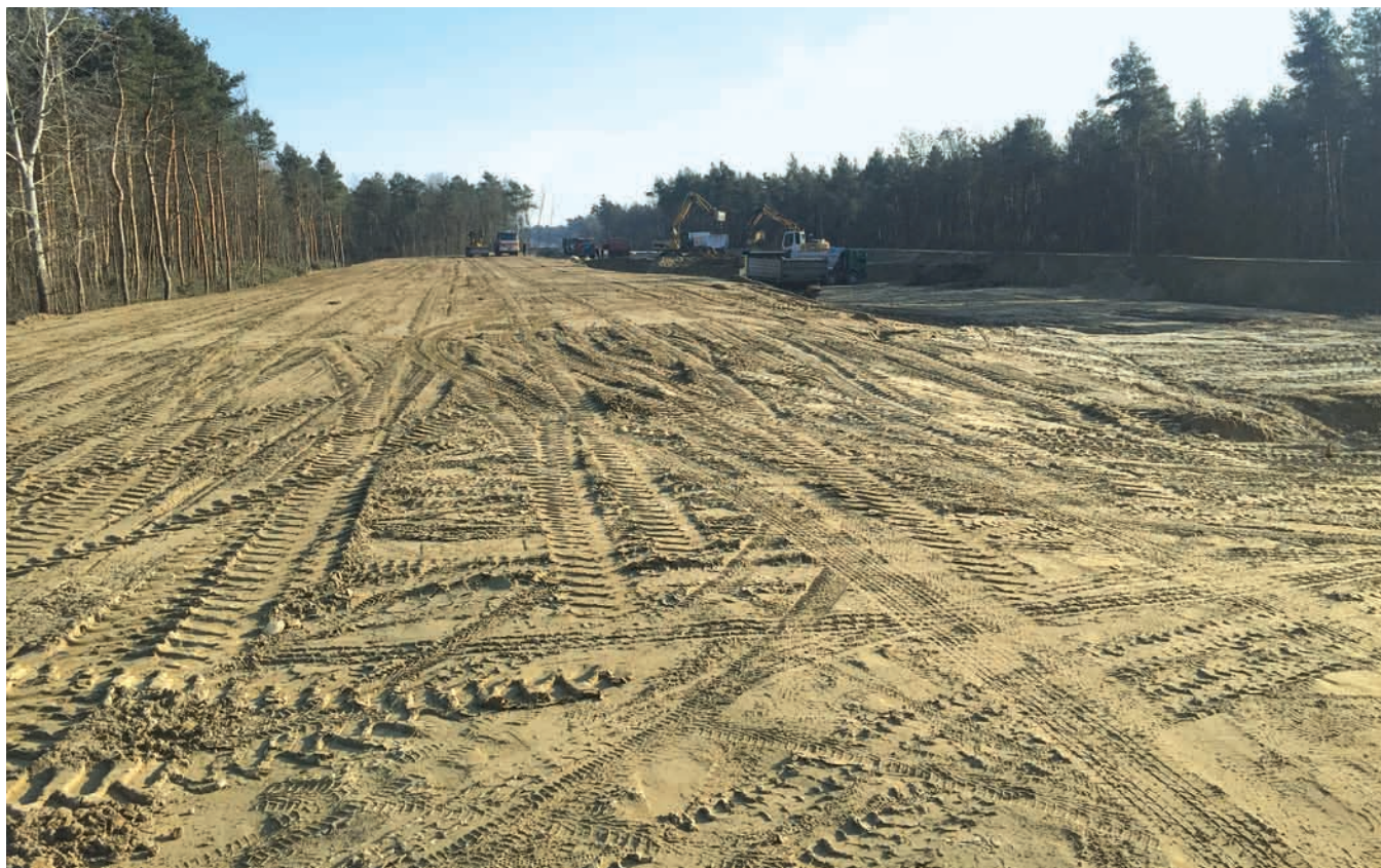
26. ábra: A humusz eltávolítását követő területrendezés
