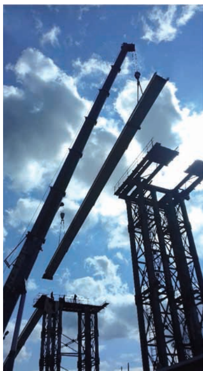
87. ábra: Párosított ívelemek beemelése
