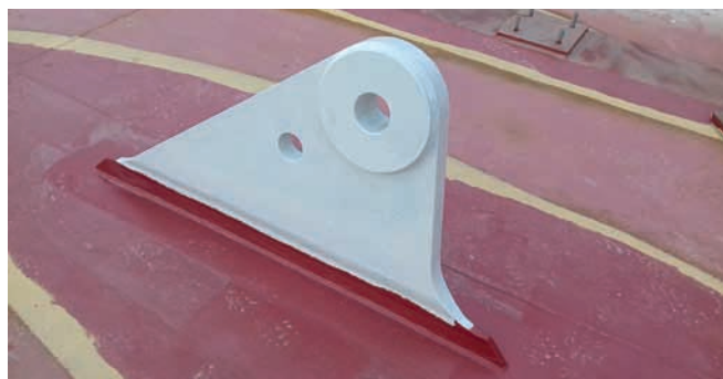
98. ábra: Bekötőfül a merevítőtartón
