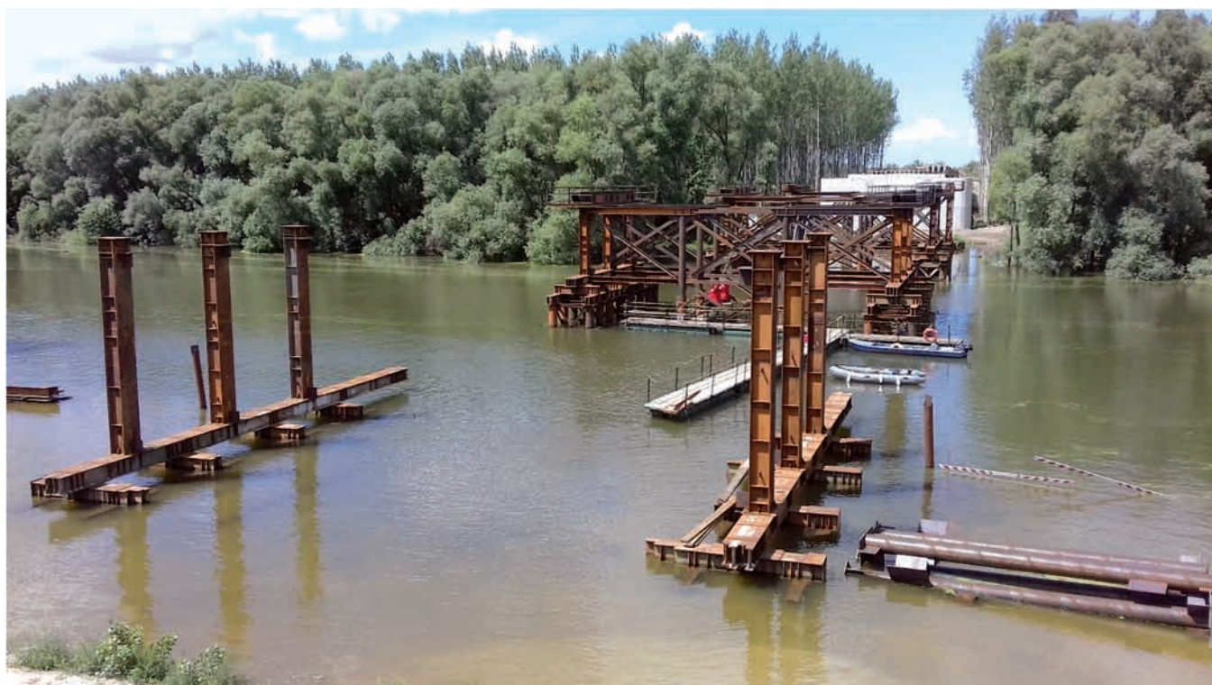
106. ábra: „A” járom készülő felszerkezete
