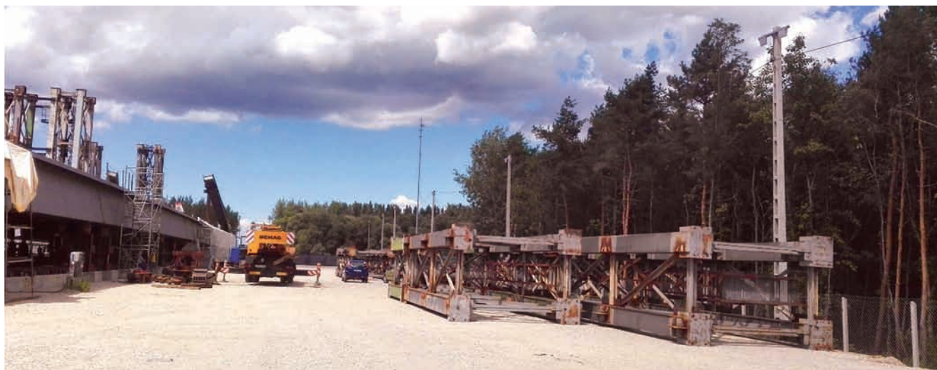
78. ábra: Ívtartó állványok építés alatt
