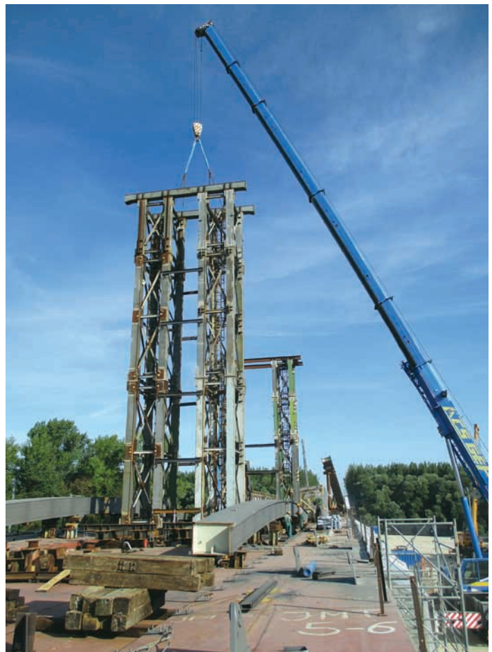
77. ábra: Kettős nehézállványok
