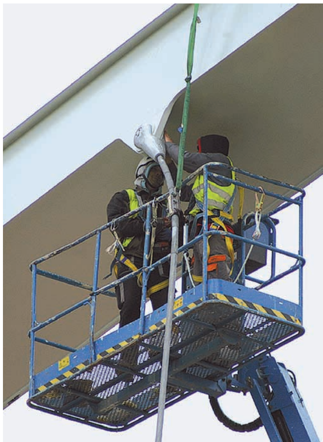
94. ábra: Függesztőkábel ívbe való bekötése
