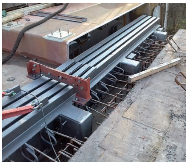
137. ábra: Dilatációs szerkezet behelyezése
