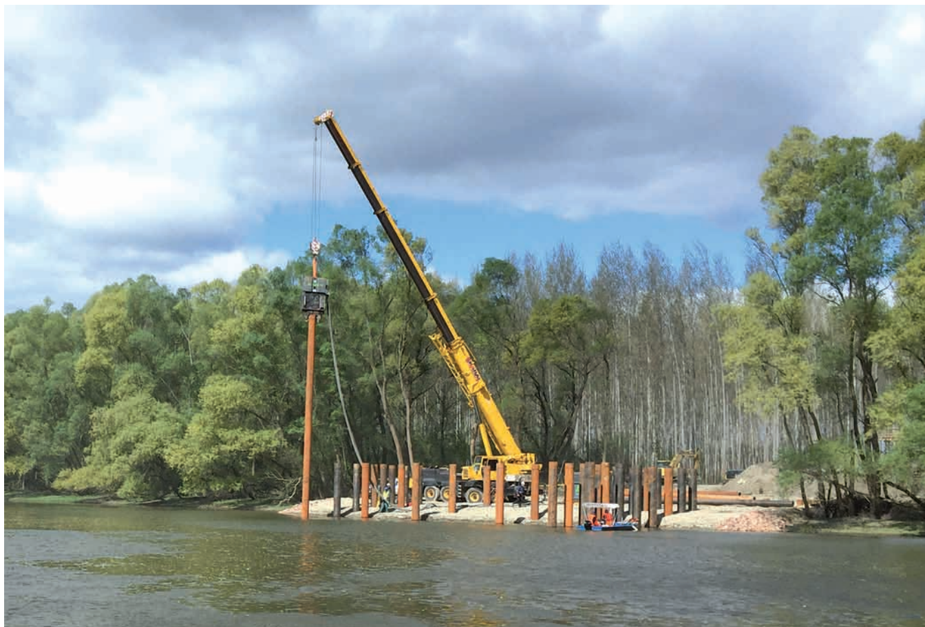
102. ábra: Parti járom cölöpjének vibrálása
