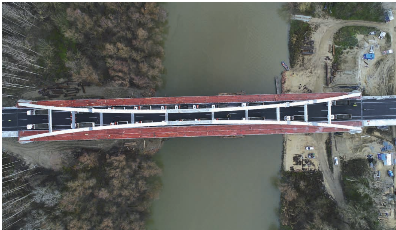
158. ábra: A mederhíd próbaterhelése felülnézetben
