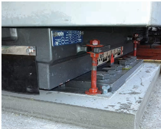
132. ábra: Beépített saruszerkezet
