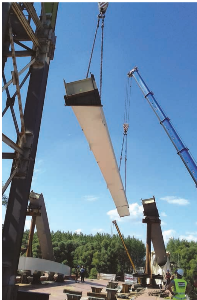
84. ábra: Párosított ívszegmens próbaemelése a ráhagyás méréséhez
