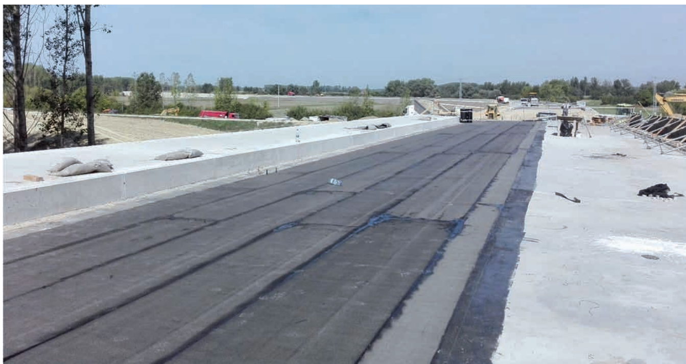
154. ábra: Elkészült kocsipálya lemezszigetelése
