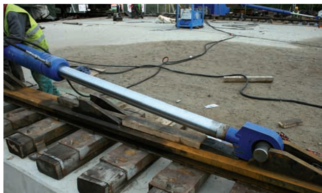
123. ábra: Munkahenger tolás közben
