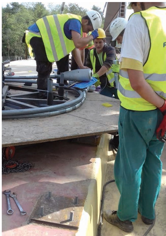
92. ábra: Függesztőkábelek lehajtása a tekercsasztalról
