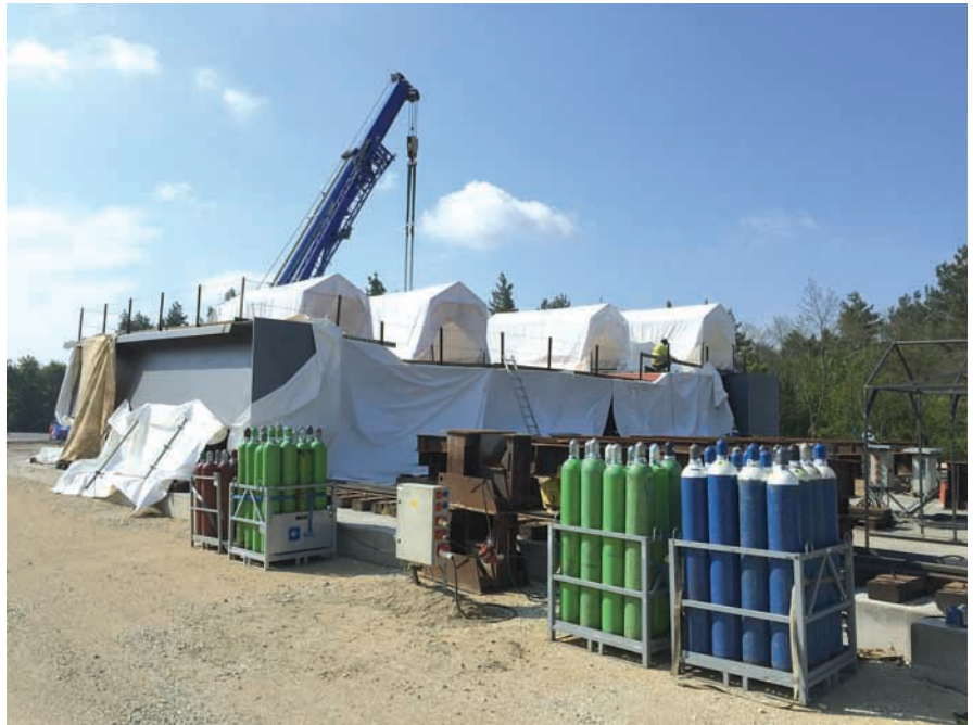
69. ábra: Pályaegység helyszíni illesztése
