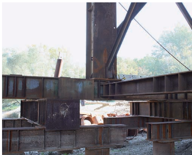
104. ábra: Parti járom felszerkezetének részlete
