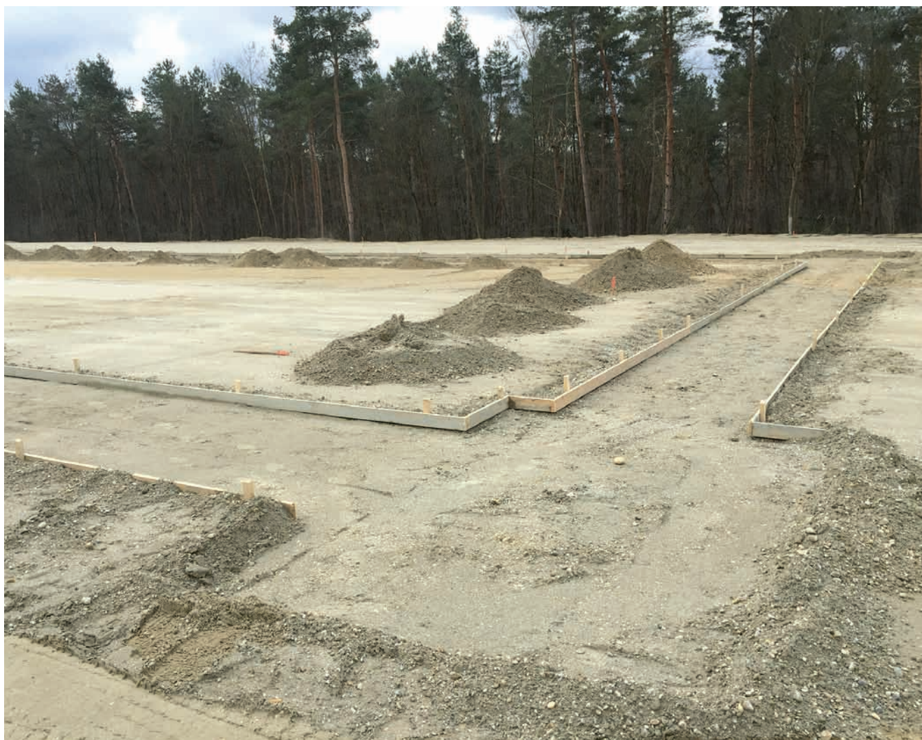
29. ábra: Szerelőtér kitűzése, szerelőbeton zsaluzata
