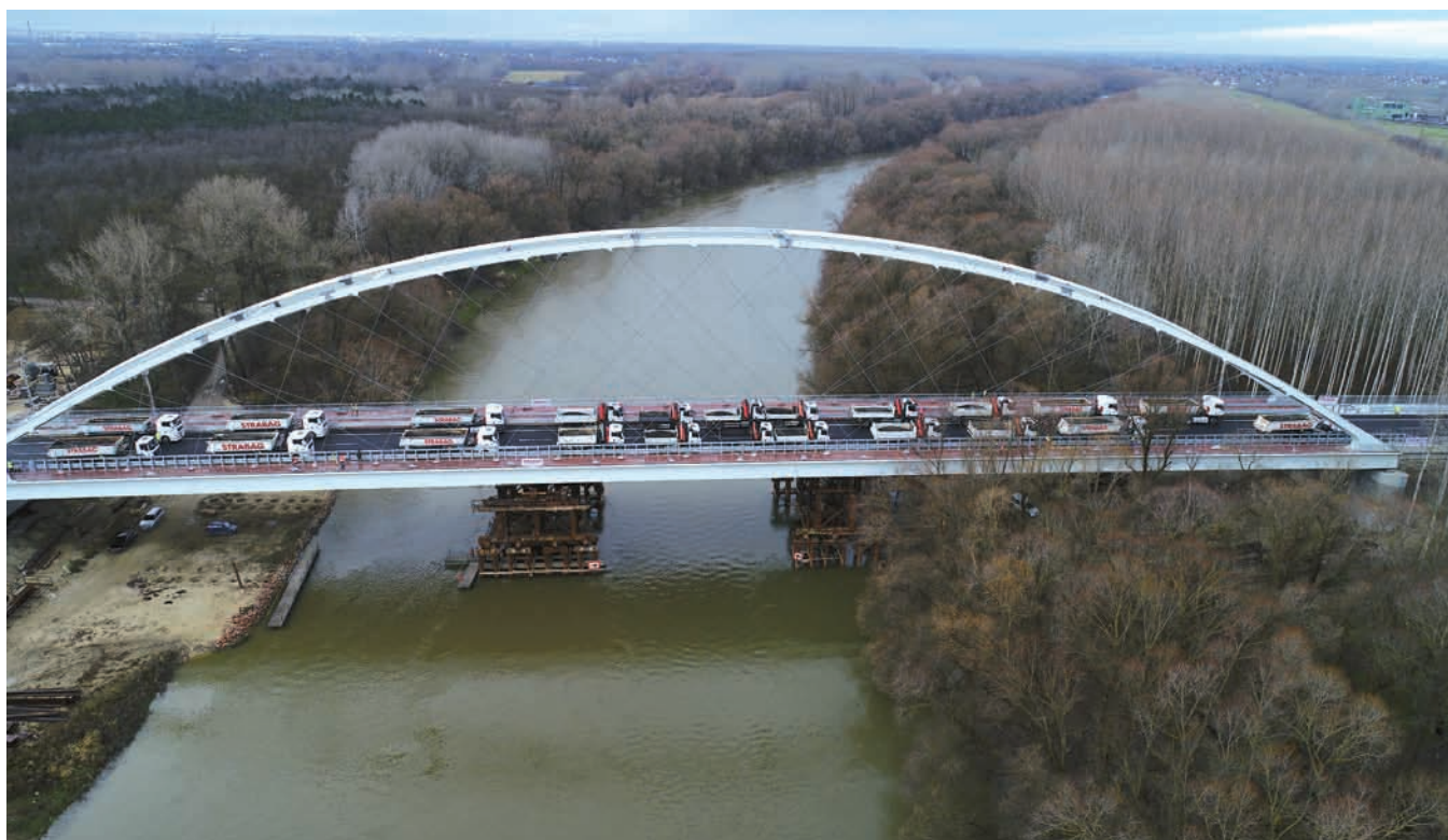
157. ábra: A mederhíd terhelése
