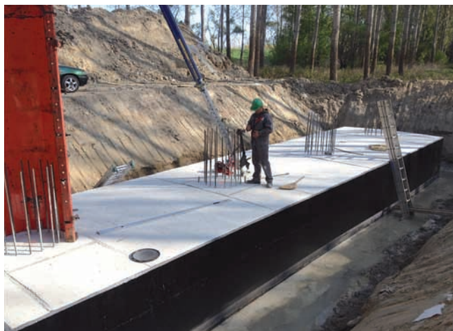
151. ábra: Plastimul Fiber felhordás után
