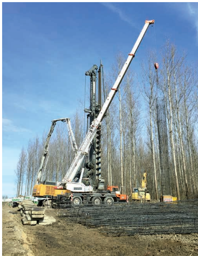
35. ábra: Cölöpök készítése és az armatúra elhelyezése
