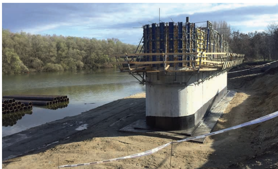
39. ábra: Készülő 2-es pillér és a talajnedvesség elleni szigetelés
