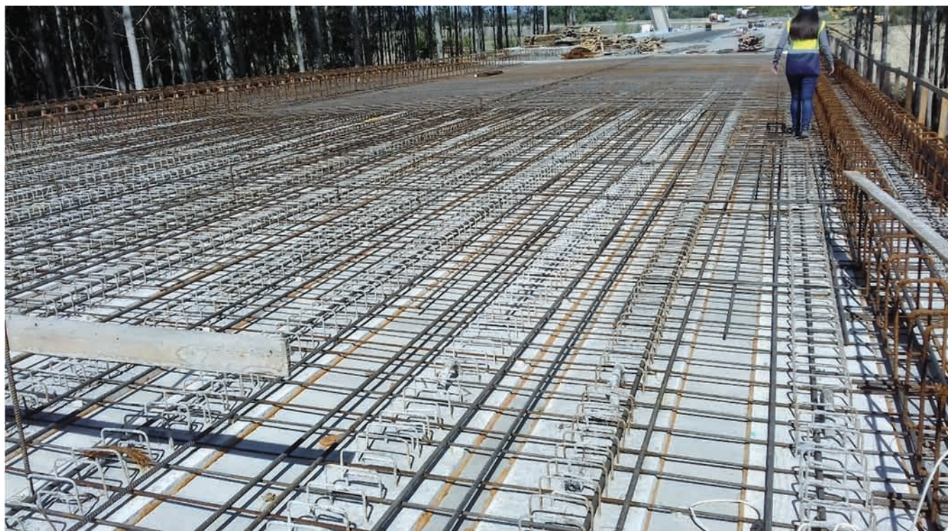
50. ábra: Készülő vasszerelés
