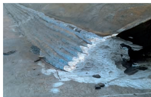
81. ábra: Elkészült írvég és pálya varrata
