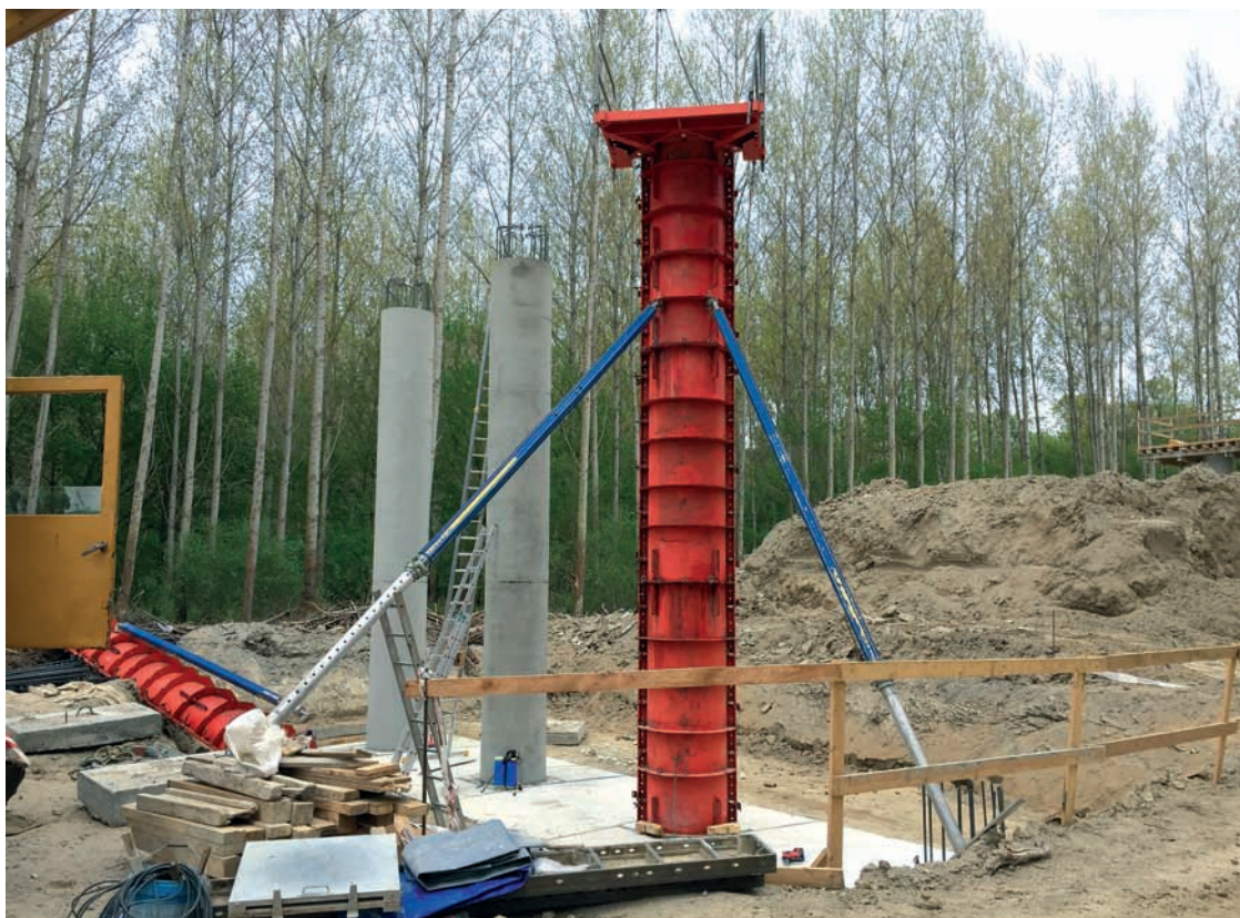
41. ábra: Vasbeton oszlopok zsaluzása
