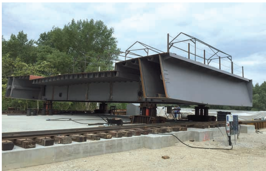
65. ábra: Hátrahúzott pályaeegység ideiglenes bakrendszeren
