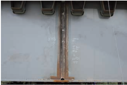
68. ábra: Kereszttartó gerinclemezének helyszíni illesztése és varrat minőségének ellenőrzése
