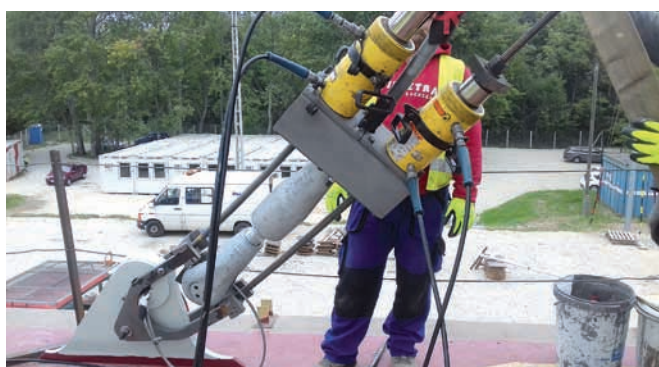
97. ábra: Függesztőkábel behúzatása és kiegyenesítése
