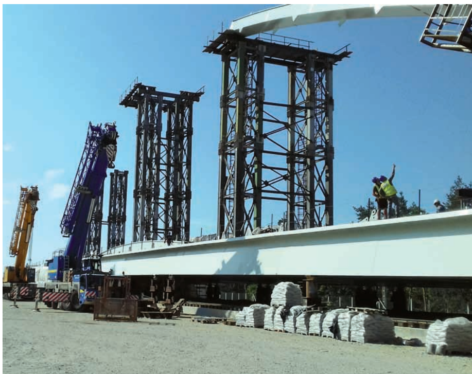
88. ábra: Ívtartó elemek párosítása a pályán
