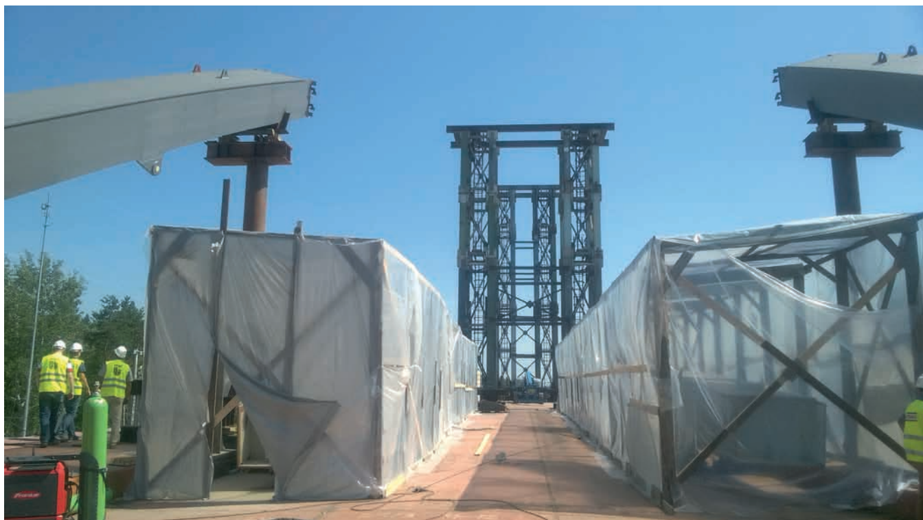
149. ábra: Beállványozott ívpárok a pályalemezen
