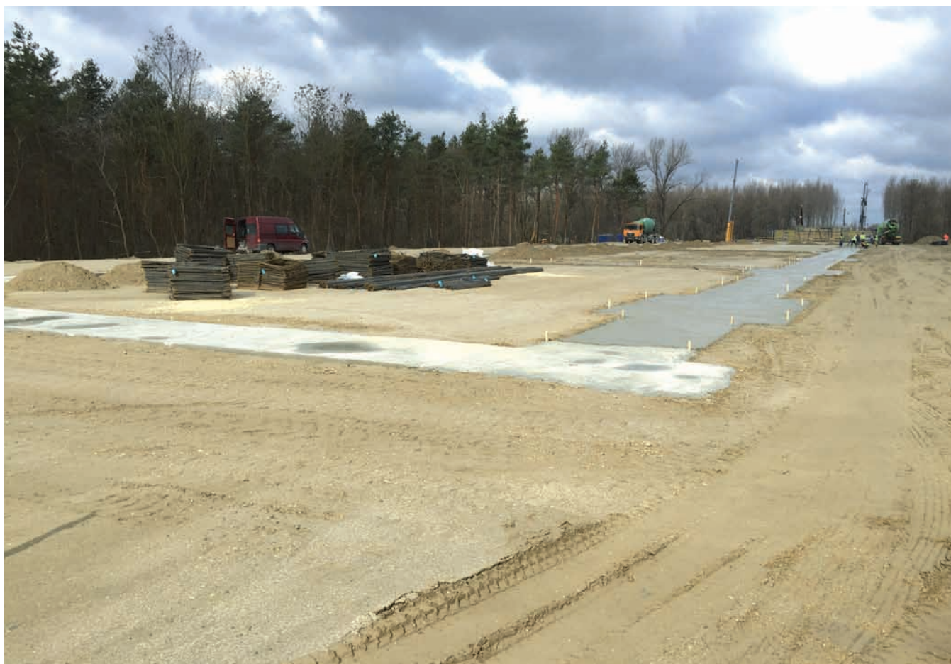
30. ábra: Elkészült szerelőbeton
