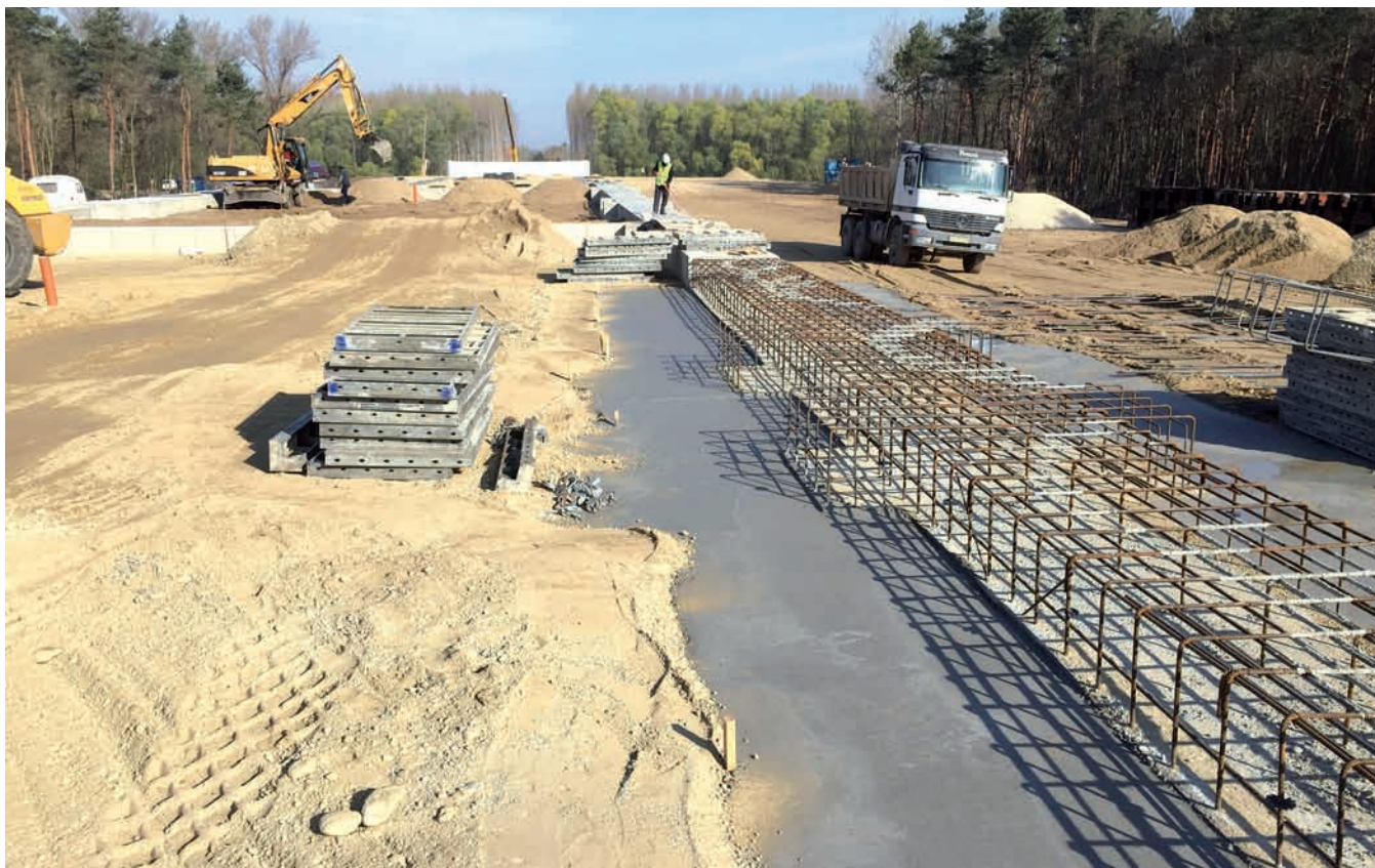
31. ábra: Szerelőtér gerendarács-szerkezetének vasalása
