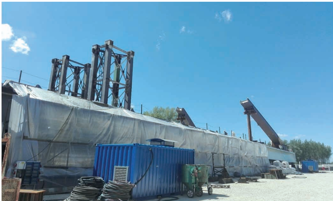
148. ábra: Helyszíni festés sátor alatt
