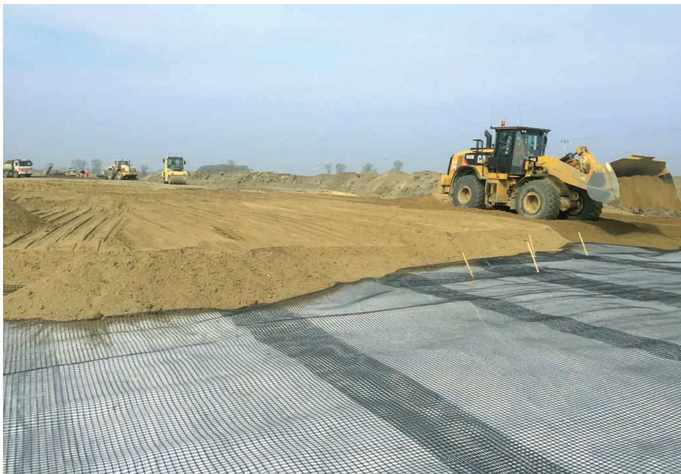
27. ábra: Beépített geotextília és georács a töltésalapozás alatt
