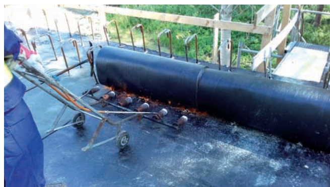
152. ábra: Bitumenes lemezszigetelés készítése
