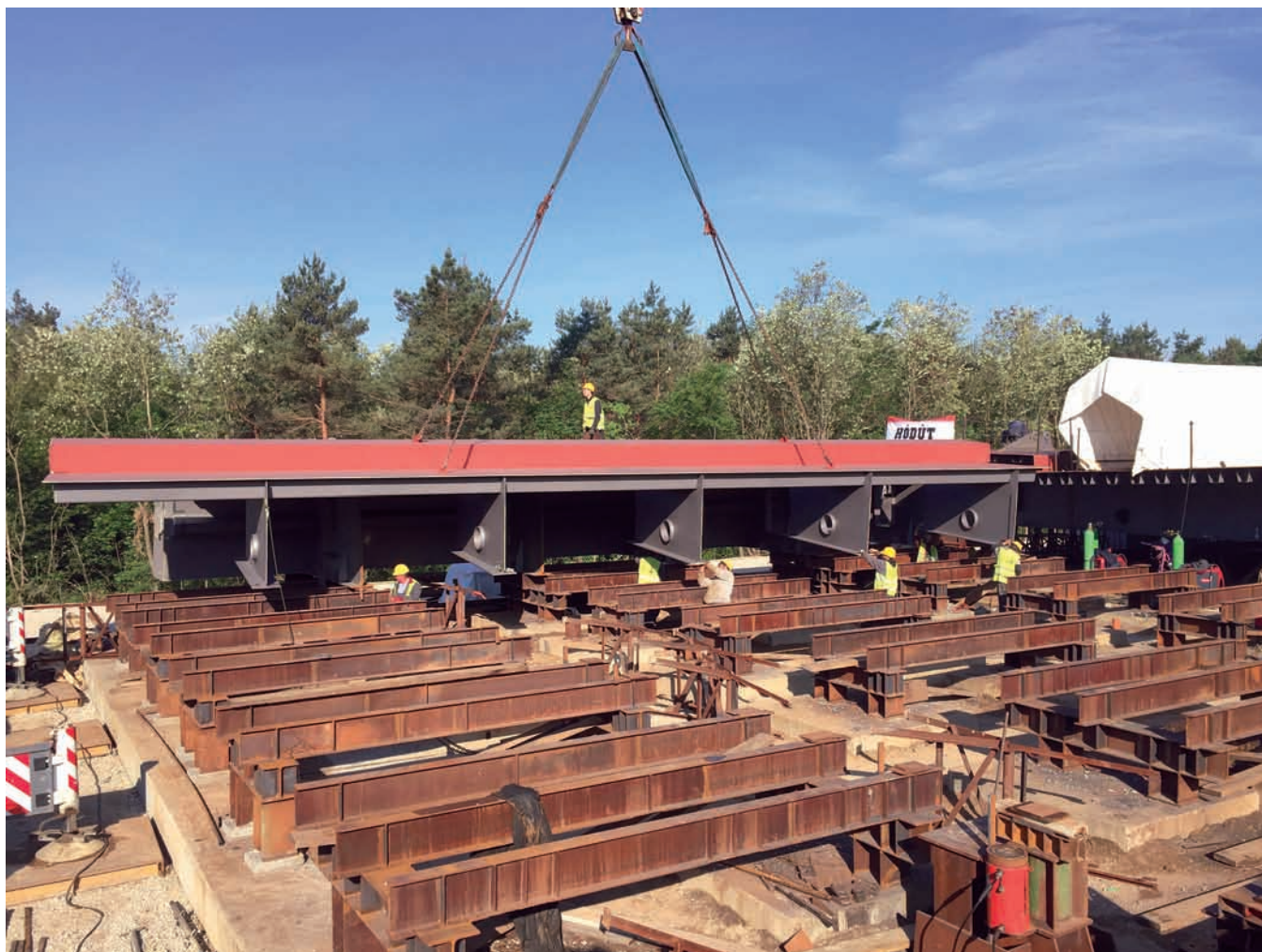
61. ábra: BMT jelű elem beemelése közben
