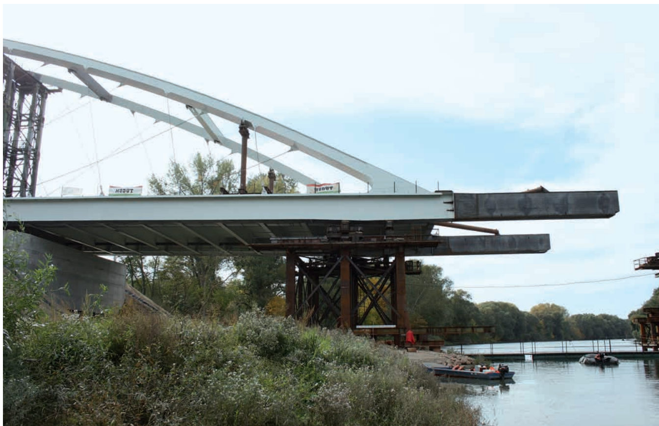
126. ábra: Konzolos állapotban „A” és „B” járom között
