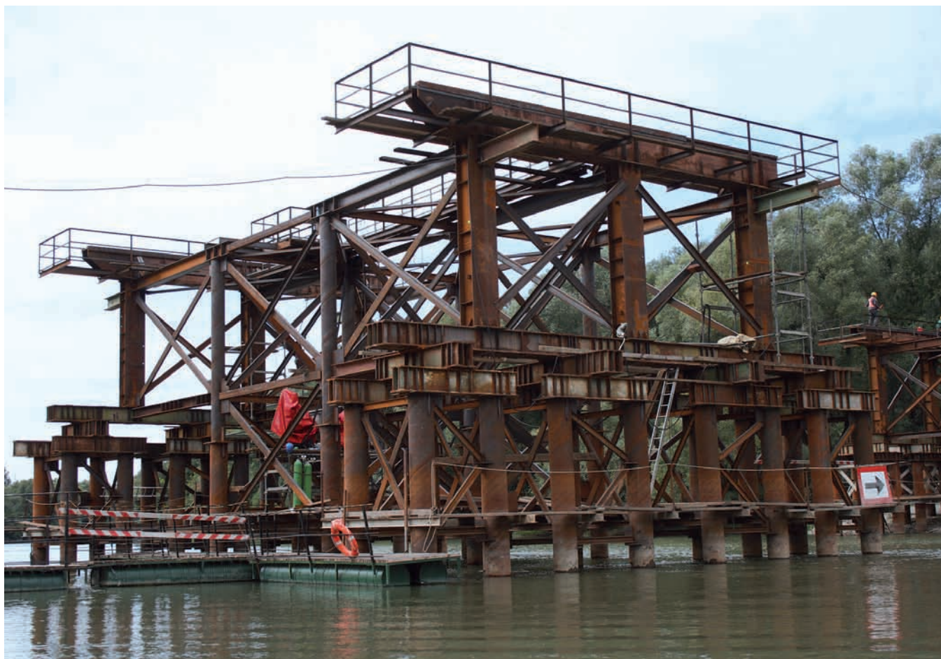
107. ábra: Elkészült vízi járom
