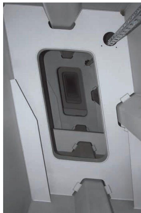
58. ábra: Merevítőtartó belseje a felületkezelés után
