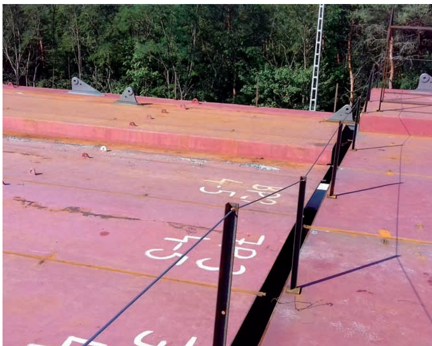
57. ábra: Pályaelemek jelölése a valóságban
