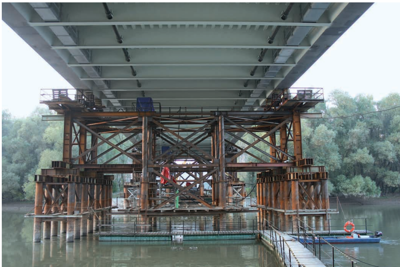
127. ábra: A vízi járom és a felette elhelyezkedő mederhíd
