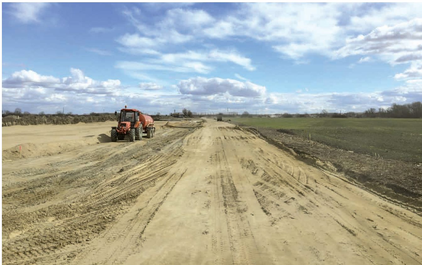
28. ábra: Épülő töltés
