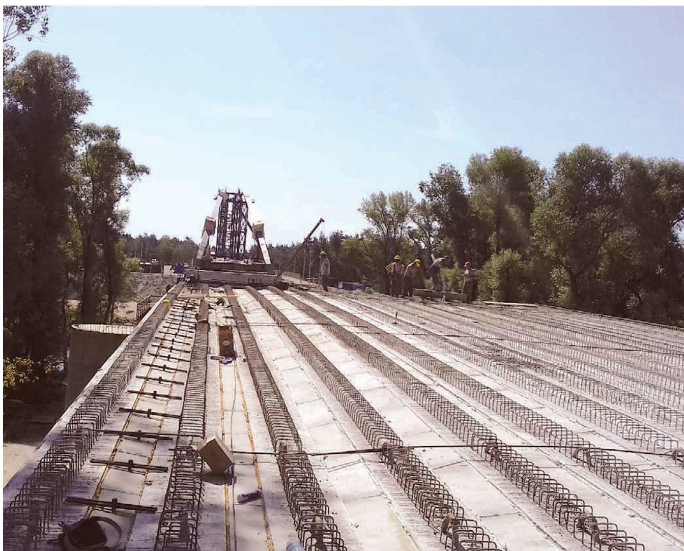
47. ábra: Gerendák a beemelés után közöttük a Betonyp lapokkal
