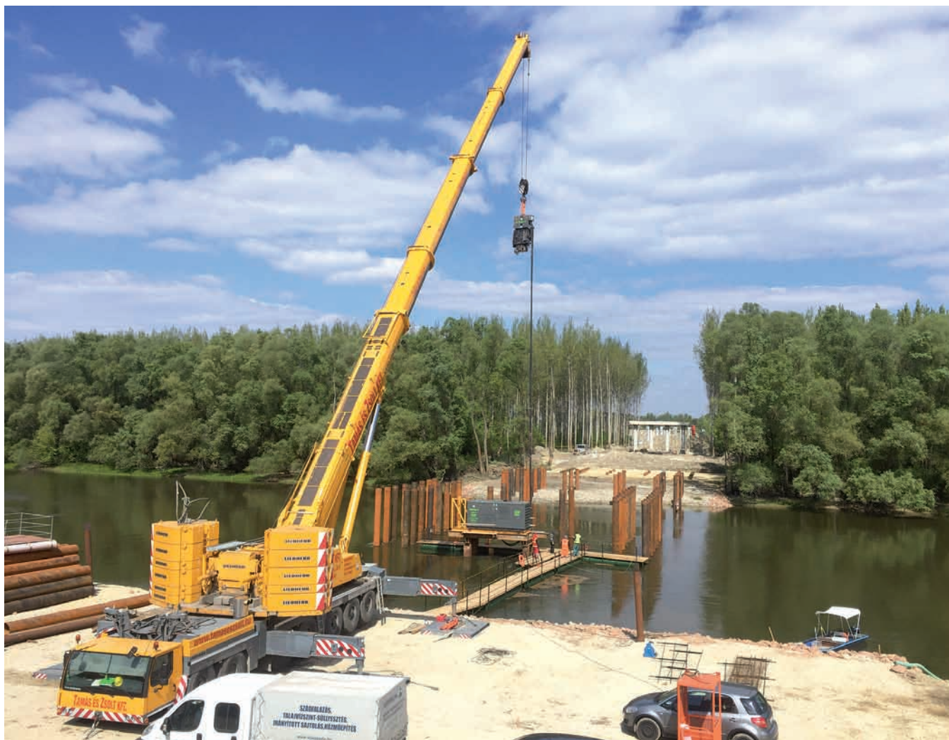
103. ábra: Vízi jármok csőcölöpjeinek elhelyezése
