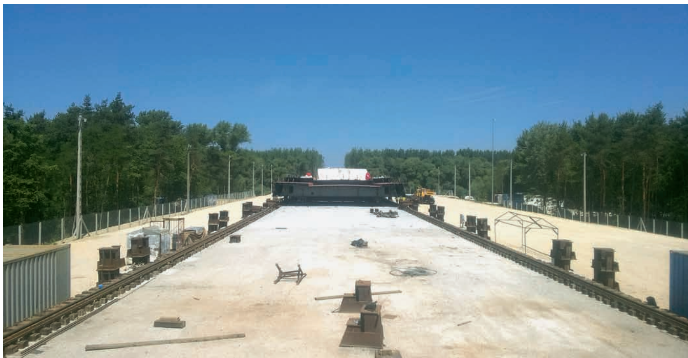
34. ábra: Szerelőtér, Mosoni-Duna felőli oldalán az elkészült keresztmetszetekkel
