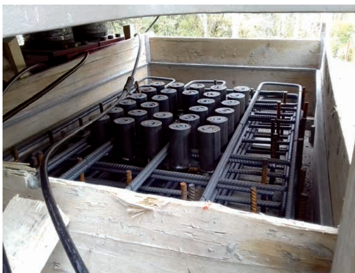
138. ábra: Mederhíd saruzsámoly vasalása és zsaluzása
