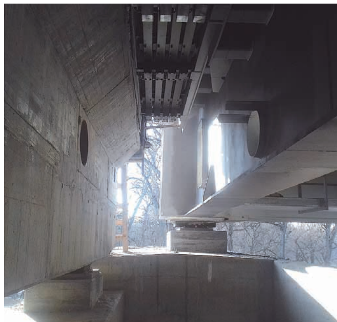
134. ábra: Vizsgáló „árok” és a dilatációs szerkezet
