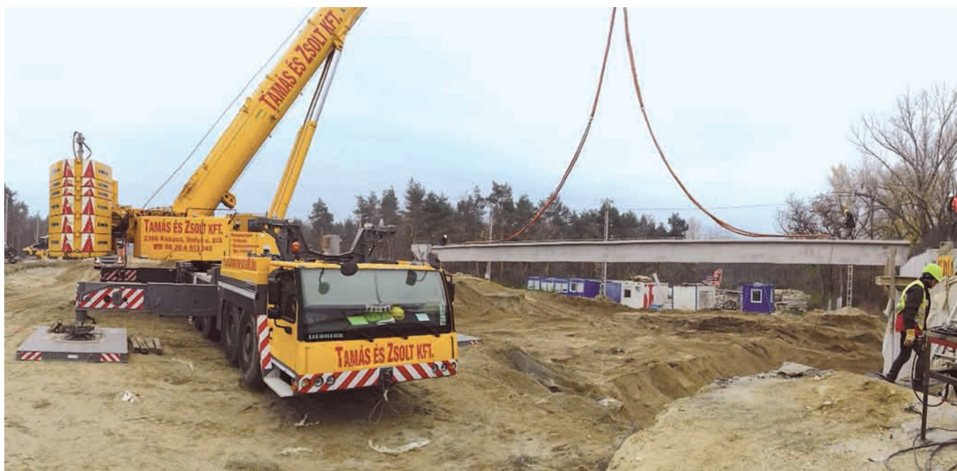
46. ábra: A jobb parti ártéri híd gerendáinak beemelése
