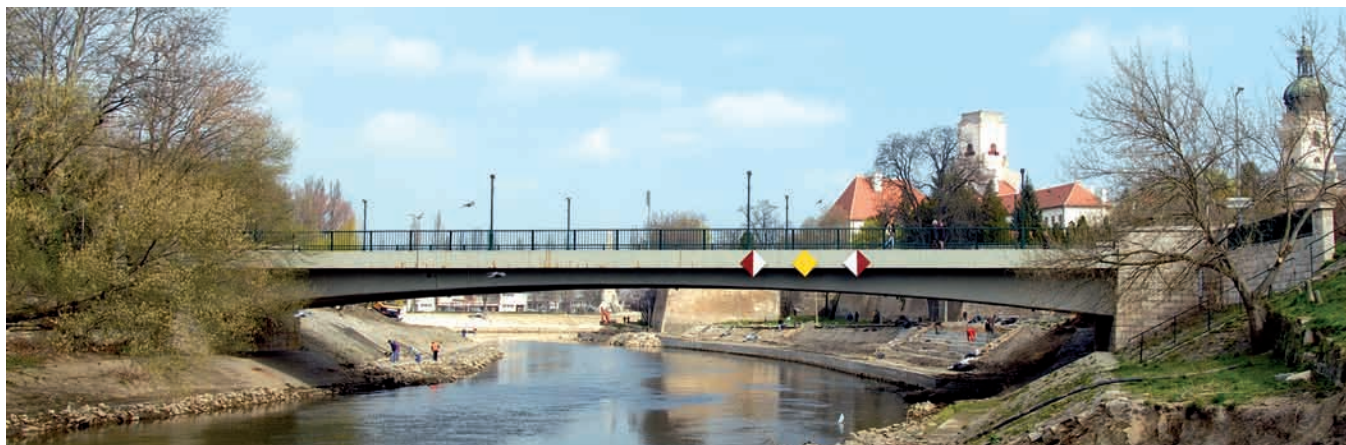
11. ábra: Rába kettős híd [9]
