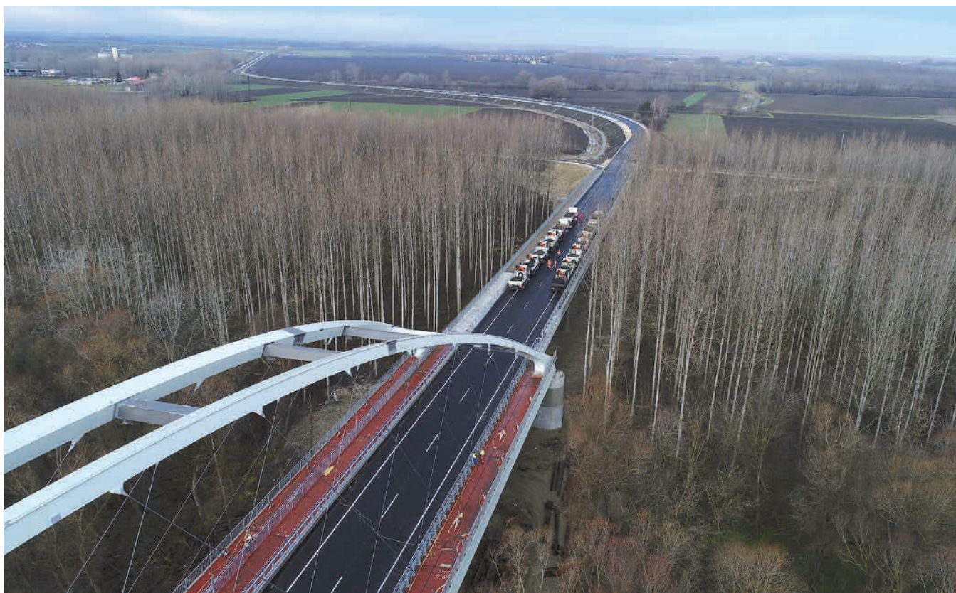
160. ábra: A bal ártéri híd terhelése
