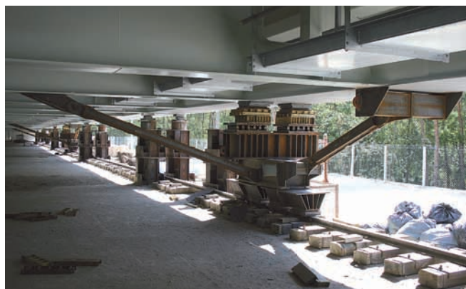
109. ábra: Csúszkakocsi és merevítése
