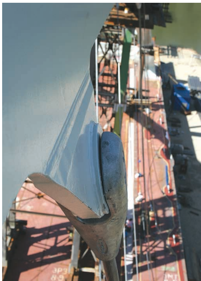
99. ábra: Függesztőkábel felső villás kialakítása
