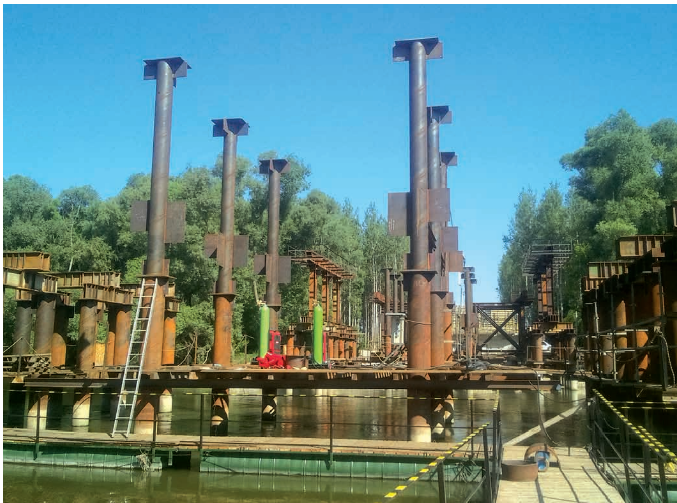
105. ábra: Csőcölöpök felszerkezetének kialakítása
