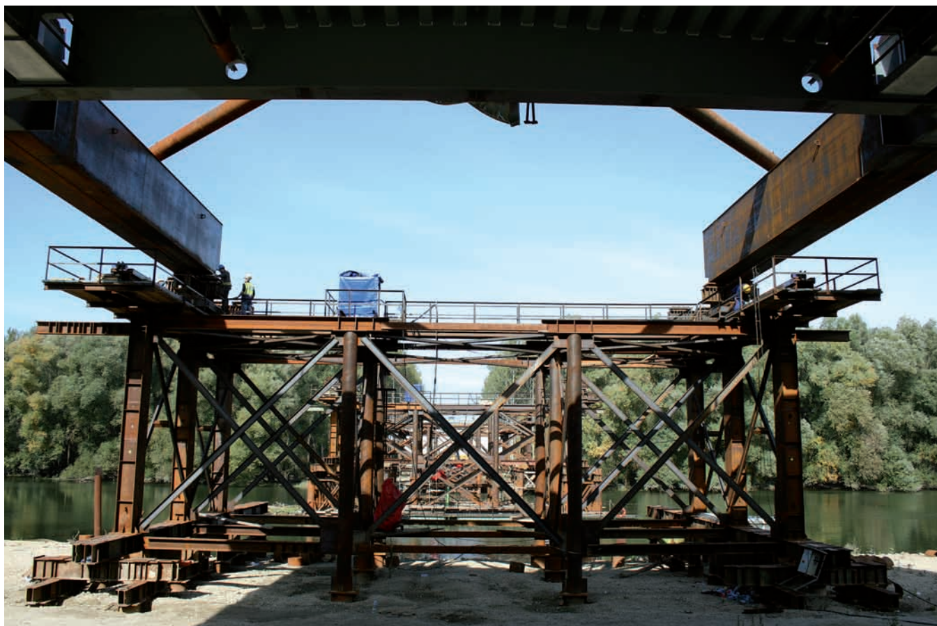
125. ábra: Az „A” jármot elért betolócsőr
