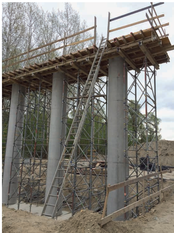
42. ábra: Szerkezeti gerenda zsaluzatának előkészítése
