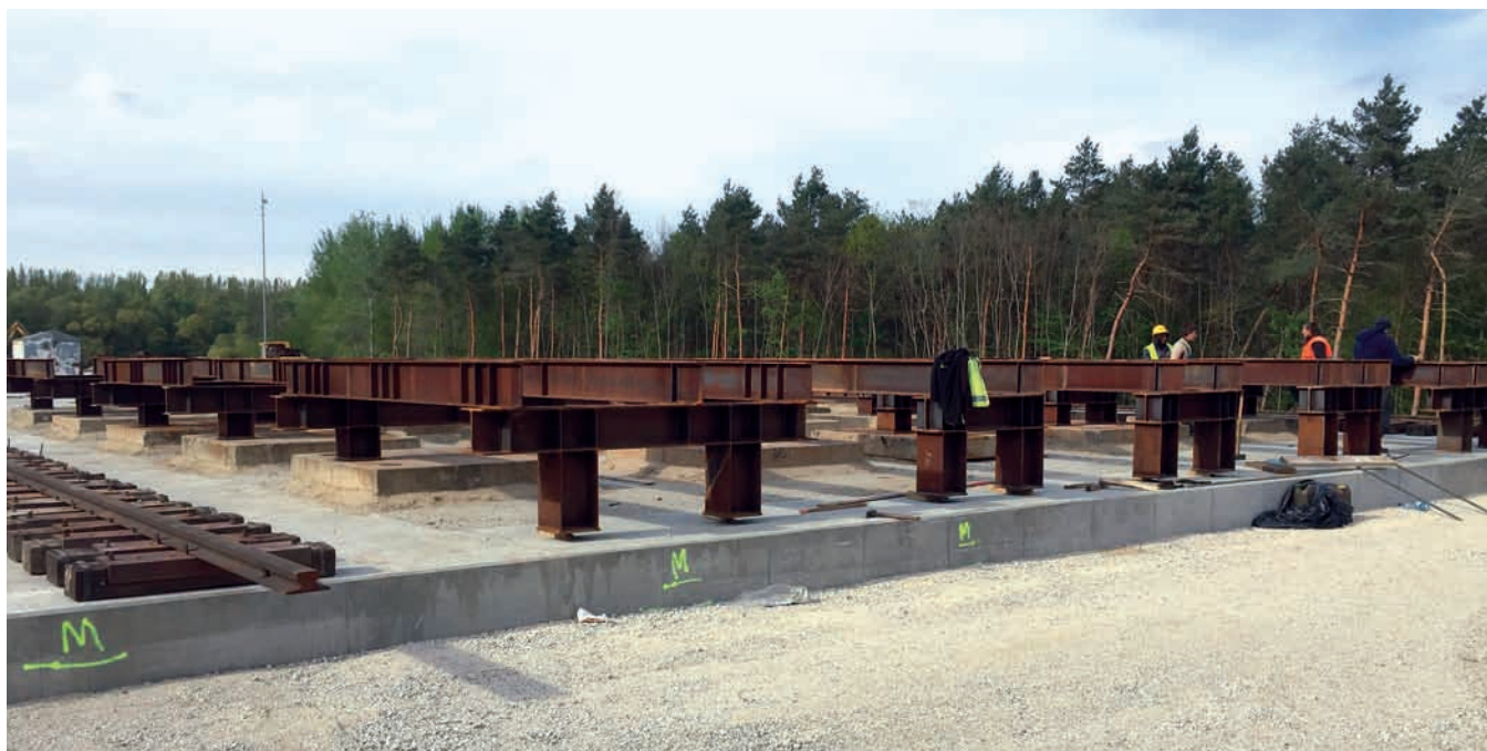
60. ábra: Szerelőpad és kialakítása
