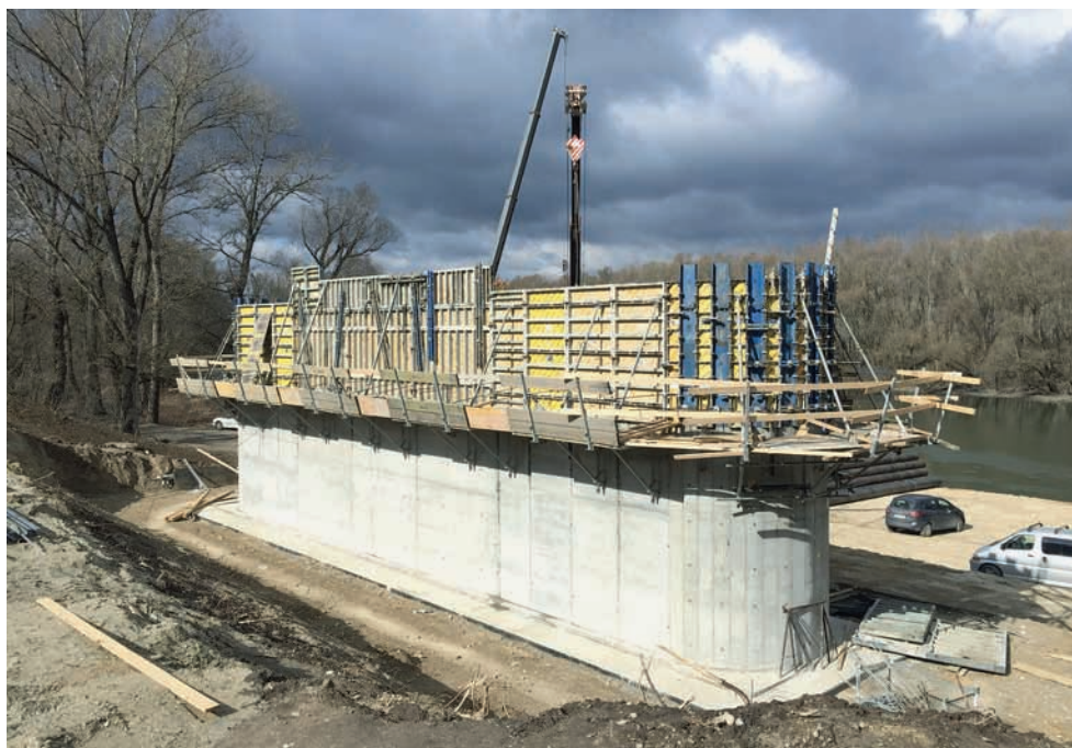
38. ábra: Épülő közös pillér és zsaluzata
