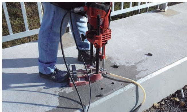
139. ábra: Vezetőkorrát talpcsavarfuratának készítése
