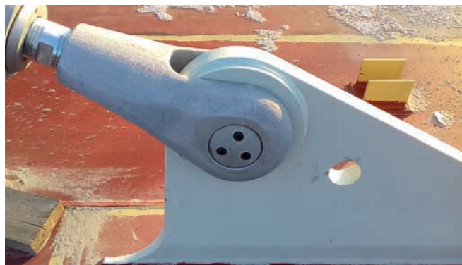
96. ábra: Beépített függesztőkábel alsó villás kapcsolata
