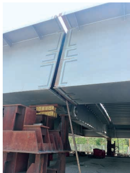
66. ábra: Pályaeegységek az egymáshoz történő rögzítés előtt
