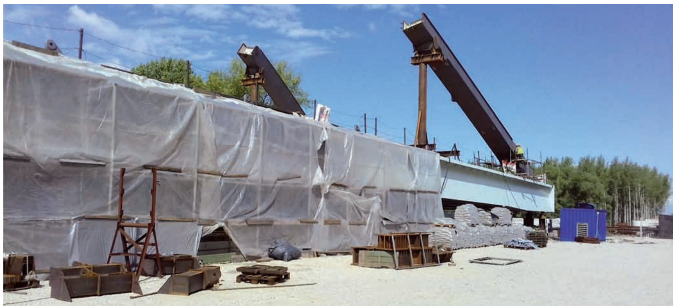
145. ábra: A mederhíd helyszíni festése
