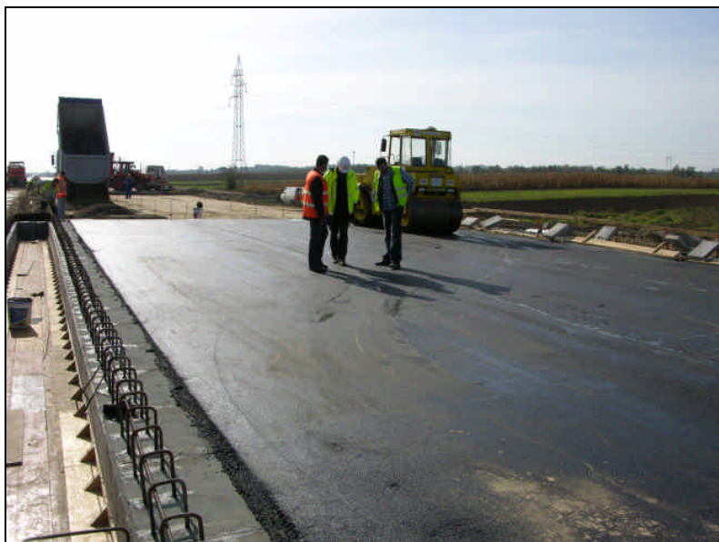
Az elkészült SAFLEX szigetelőréteg
