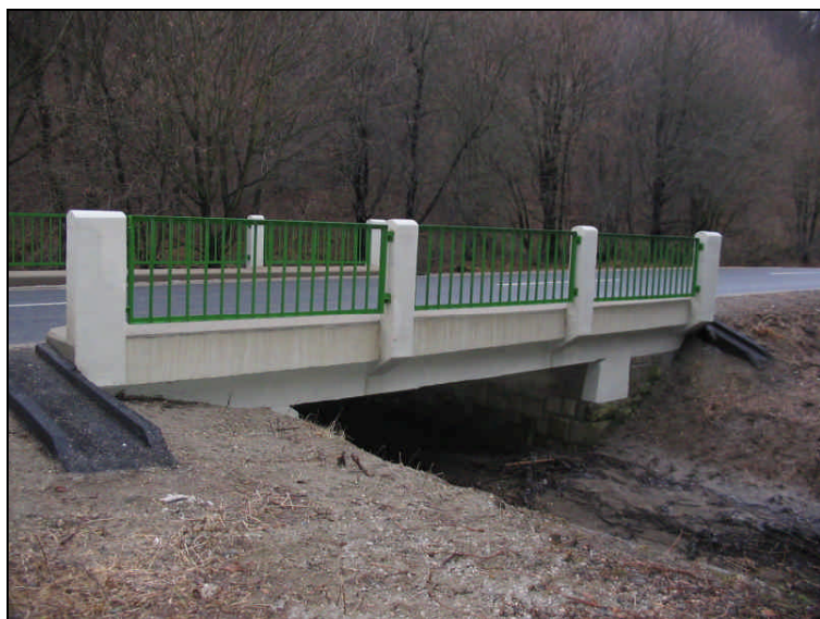
Egerbaktai Laskó-patak-híd felújítás után (Rajna József felvétele)
