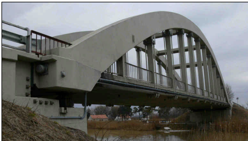
A megerősített, felújított híd
