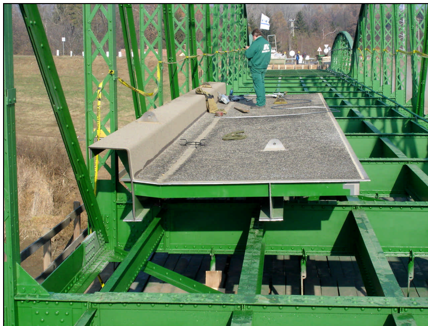
A medernyílás középső pályalemez-elemének behúzása
