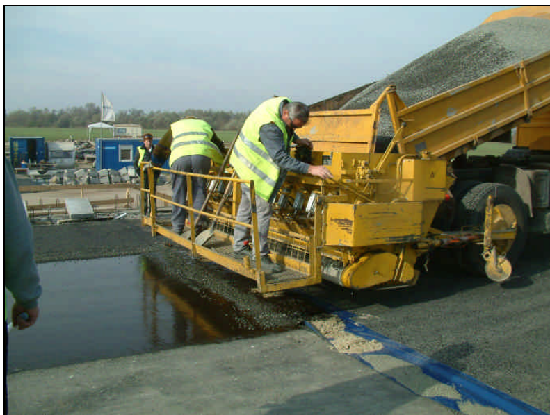
Modifikált bitumenes felületi bevonat készítése a SAFLEX szigetelőrétegre
