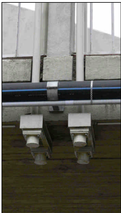
A függesztőrúd megerősítésének alsó és felső bekötése
