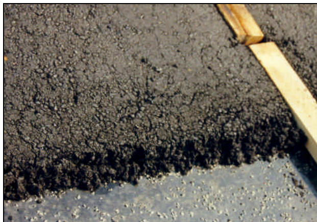
A védőaszfalt és a keresztiszívargó építése 1991-ben
