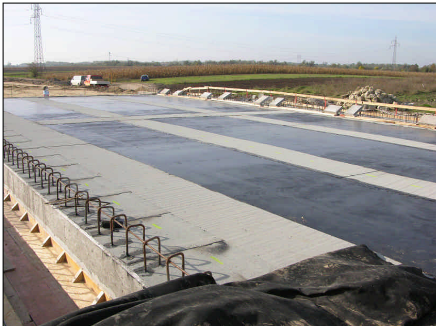
Beton pályalemez előkészítése a SAFLEX szigetelőréteghez
