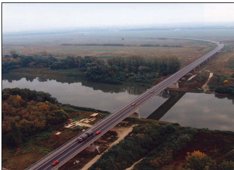
A szolnoki Szent István Tisza-híd az átadást követően
