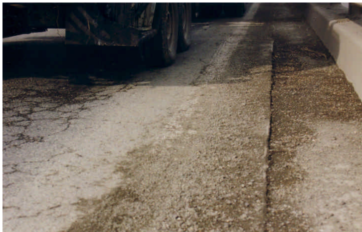
A pályaburkolat megcsúszása a baloldali szegélynél (2003)
