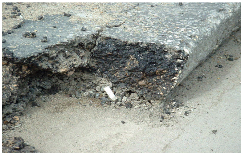
A jobb oldali burkolatsávon közlekedő járművek a szigetelésre előkészített pályalemezre gyűrték a burkolatot (2004)
