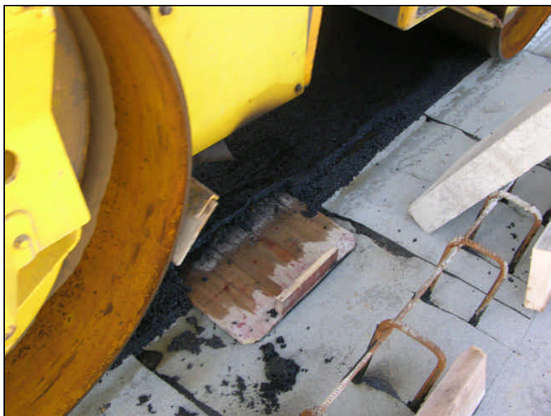
A SAFLEX szigetelőréteg csatlakozása a szegély szigeteléséhez
