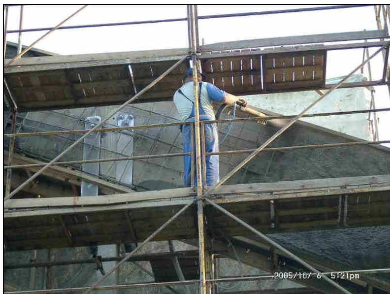
A főtartó ív erősítése lőttbetonnal
