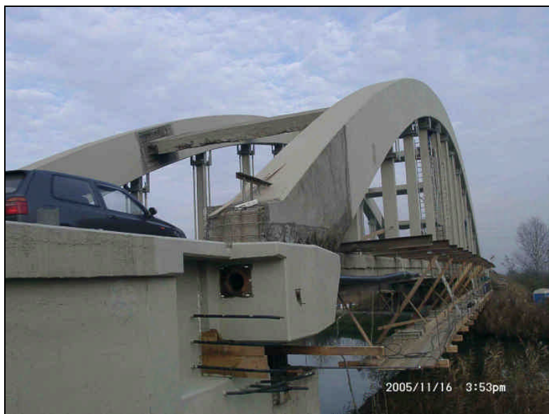
Ívek betonlövése után, a feszítés előkészítése
