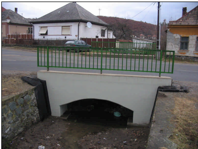
Egerbaktai szárazárok híd felújítás után (Rajna József felvétele)
