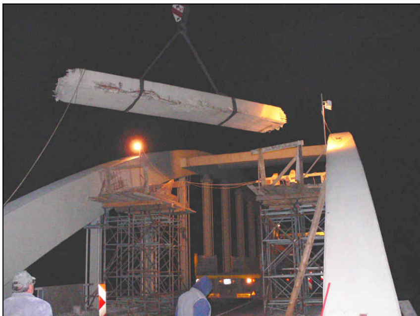
Szélső keresztkötések kivágása és kiemelése éjszaka
