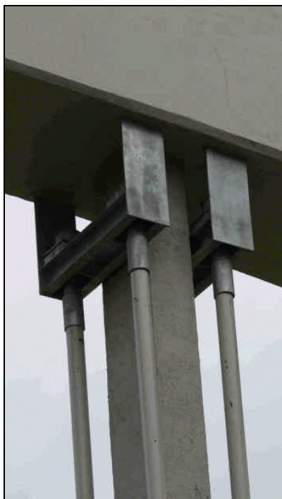
A függesztőrúd megerősítésének alsó és felső bekötése
