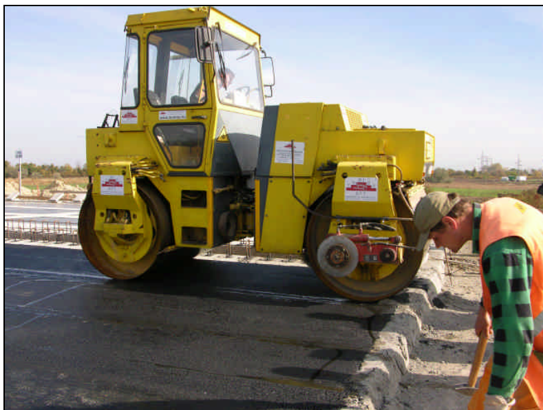
A SAFLEX szigetelőréteg tömörítése
