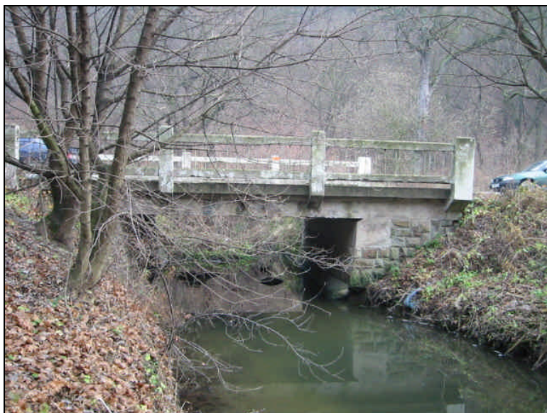
Egerbaktai Laskó-patak-híd felújítás után (Rajna József felvétele)
