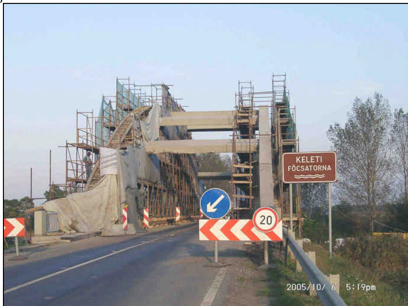
A felújításhoz beállványozott ívek (2005. október)
