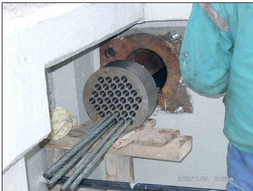
Az új feszítőpáasmák befűzése
