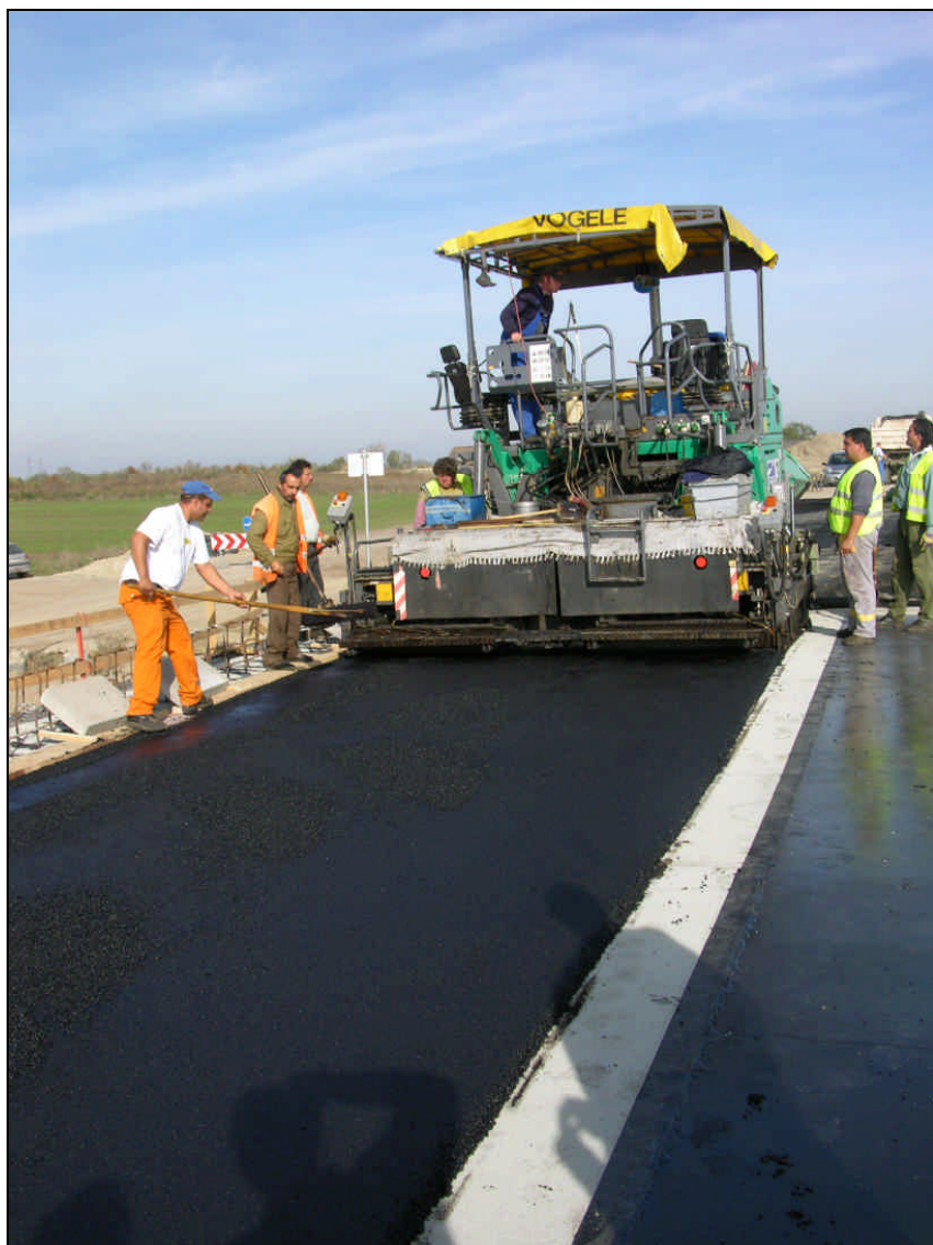
A SAFLEX szigetelőréteg terítése
