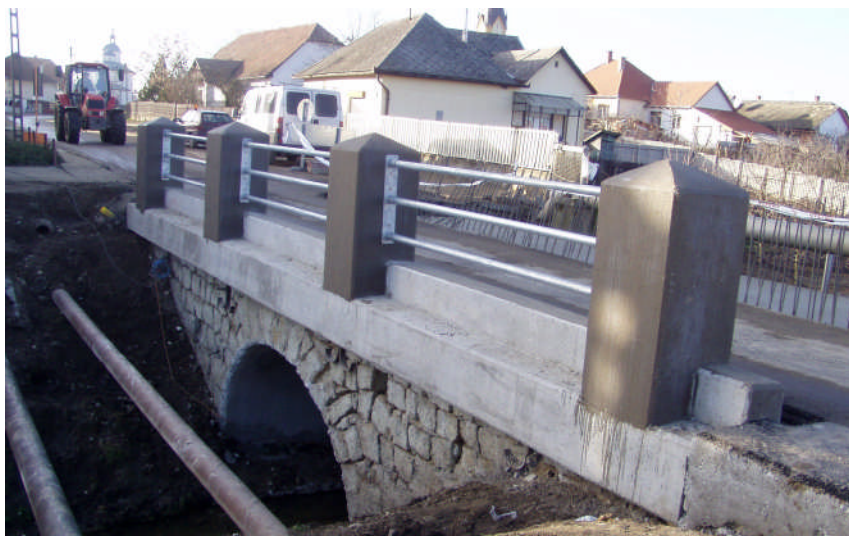
Dögei Belfő-csatorna-híd felújítása
