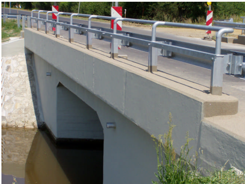
Gergelyugornyai Szipa-főcsatorna-híd felújítása
