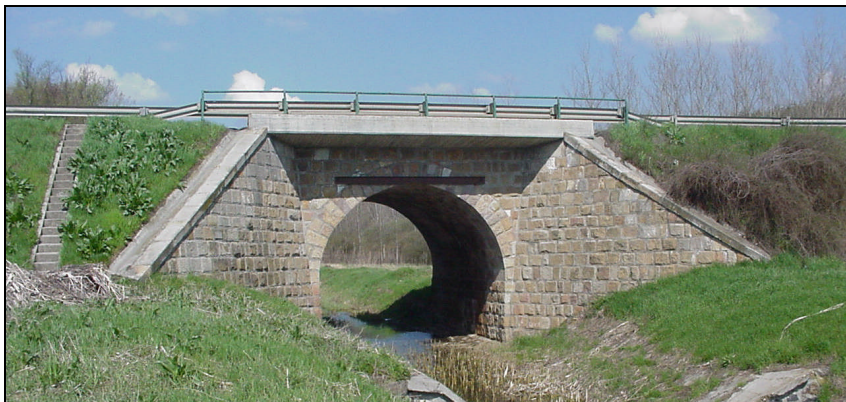
A Szendehely utáni Lókos-patak-híd (felújítva 2006-ban)
