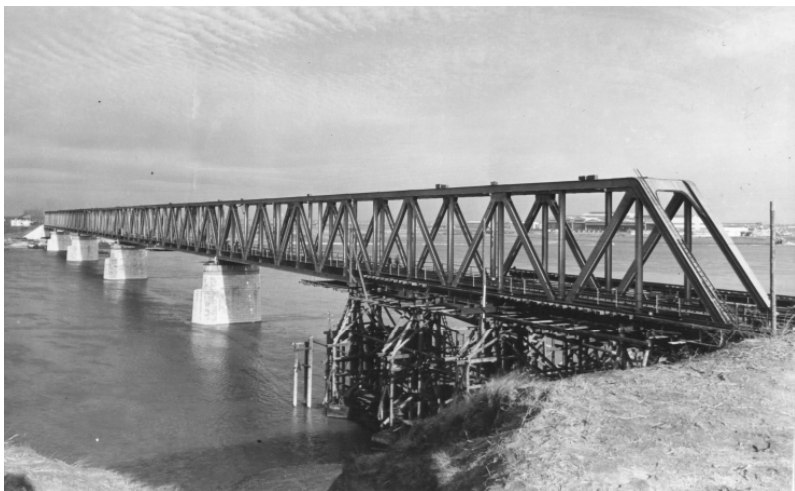
Komáromi vasúti Duna-híd építés alatt (dr. Tóth Ernő gyűjteményéből)
