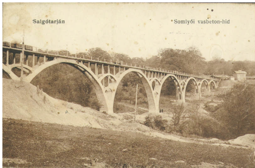
Salgótarjáni vasbeton völgyhíd (dr. Tóth Ernő gyűjteményéből)
