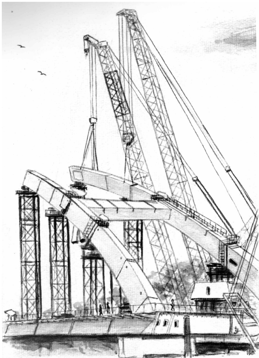
41. kép: Dunaujváros, Pentele híd: Medernyílás szerelése a bal parti szerelő platón (2006.07.20.) [PH 4]
