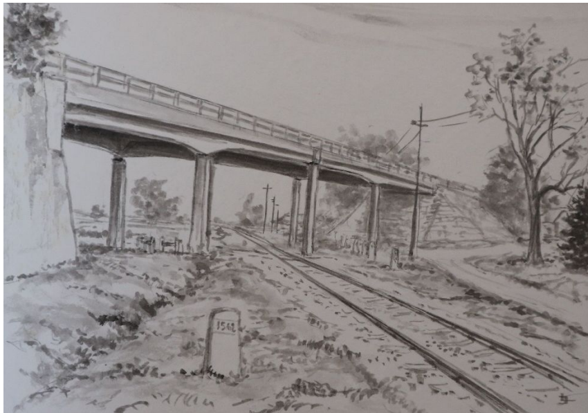
217. kép: Rátóti vasút feletti híd, 1938 [KÚM]
