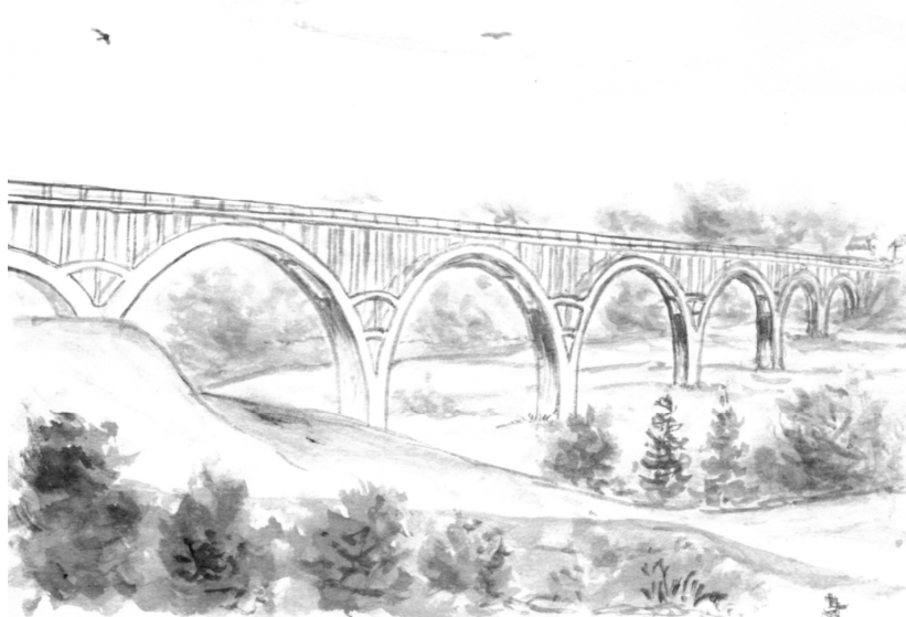
204. kép: Somlyói eltemetett bányavasúti völgyhíd, 1912 [HI 320. o.] [HN 6. o.]
