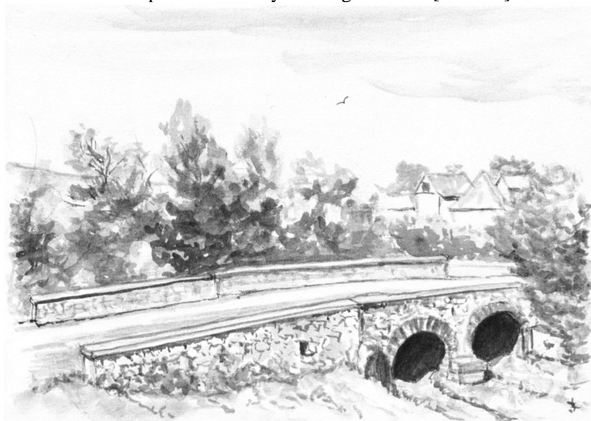
131. kép: Városlódi Torna-patak-híd [B 75. o.]
