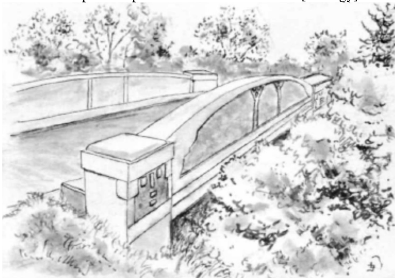
211. kép: Horvátnádajla vasbeton gerendahíd, 1909 [Hvas 31. o.]
