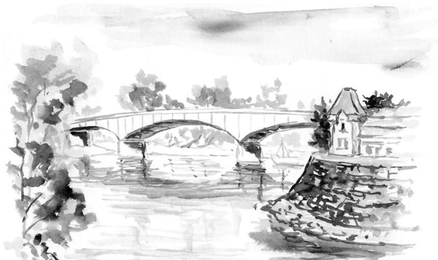
56. kép: Szolnok, Tisza-híd, 1962 [HI 135. o.] [HJNSZ 69. o.]
