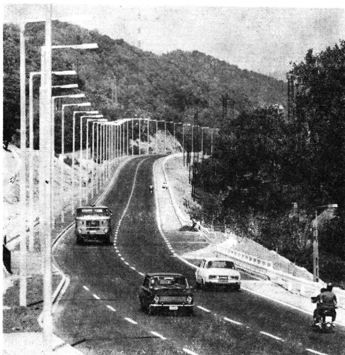
A párhuzamos szakasz építés alatt és forgalomba helyezve
