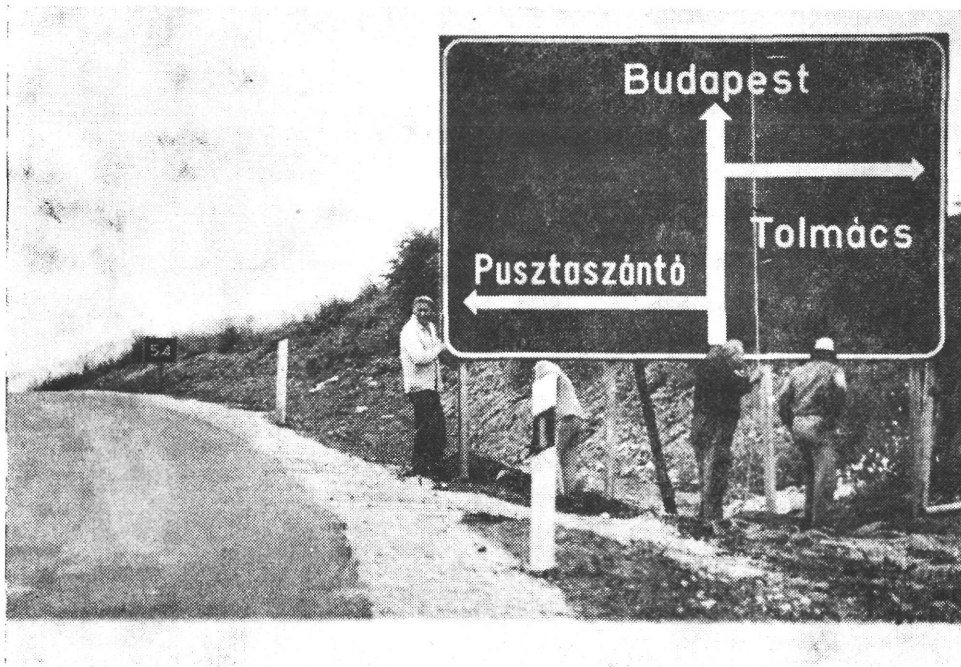
Útirányjelző tábla telepítése a 2. fkl-úton
