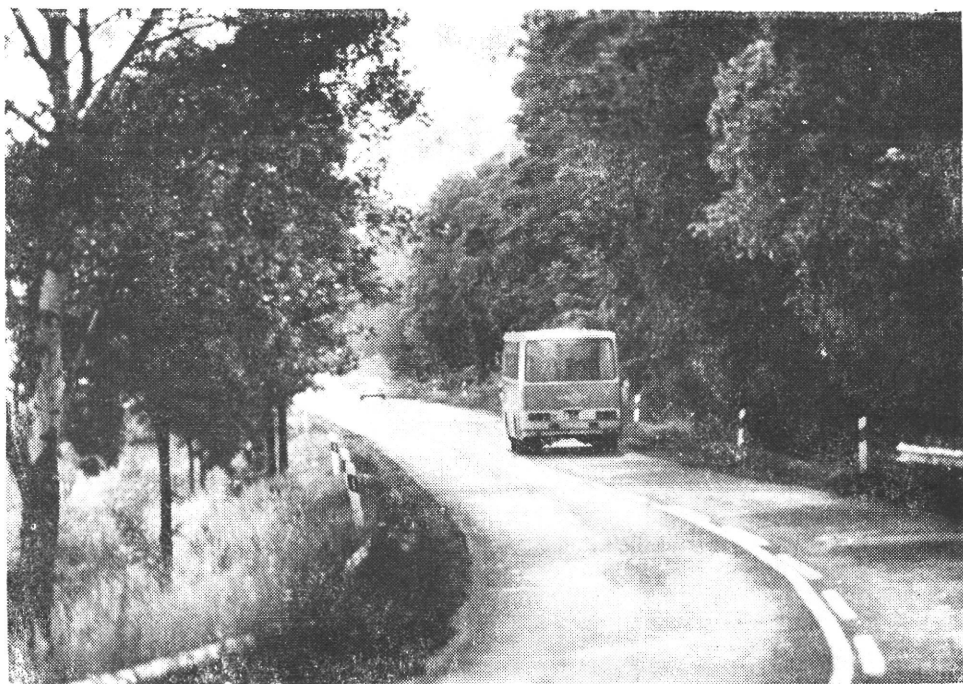
1978-ban épült pályaszerkezet-erősítés
