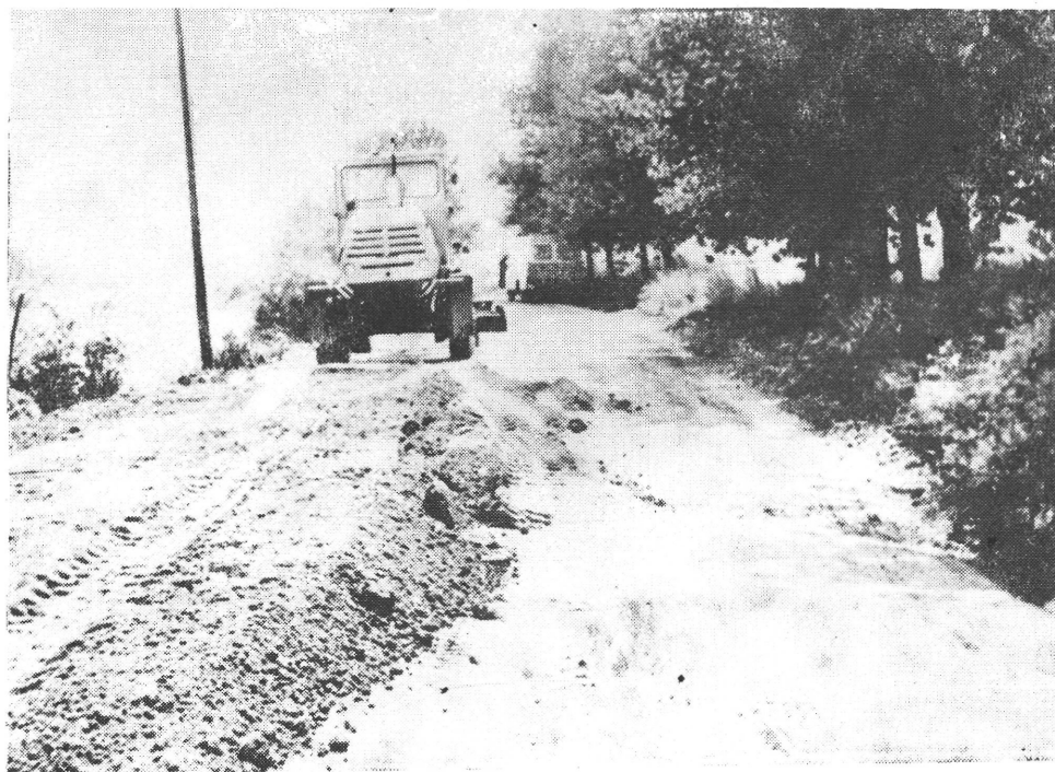
Pernyestabilizációs kísérleti útszakasz építése
