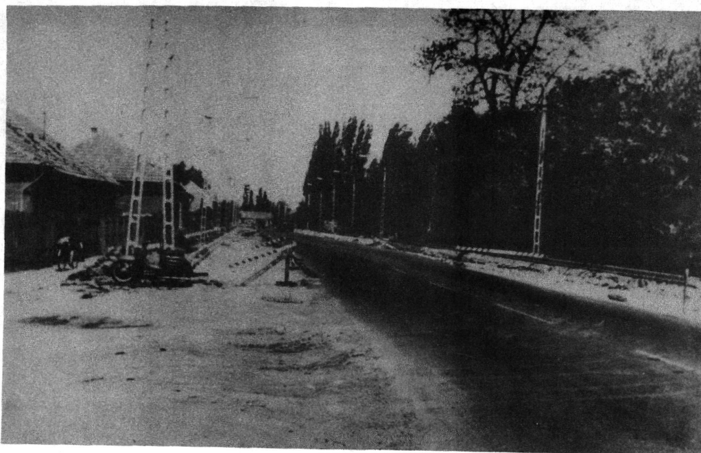
4. számú főút korszerűsítése
