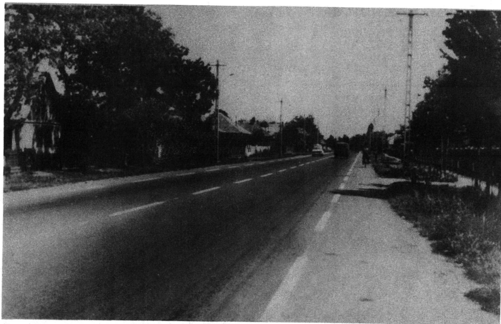
4. számú főút korszerűsítése
