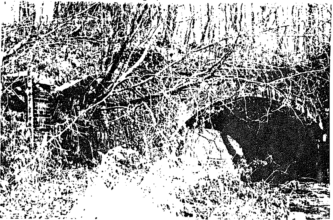
11. kép: Az elburjánzó növényzetet ki kell irtani, mielőtt súlyosan károsítaná a falazatokat.
