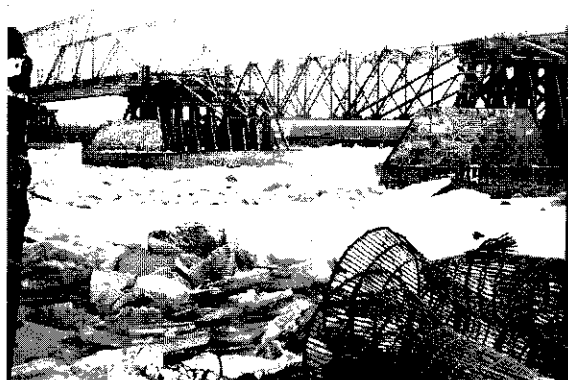
Az ideiglenes közúti híd építése
