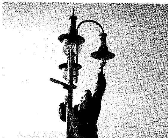
Új lámpatartó oszlopok és világítótestek szerelése
