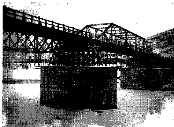
Betonsköpennyel körülvett mederjármok
