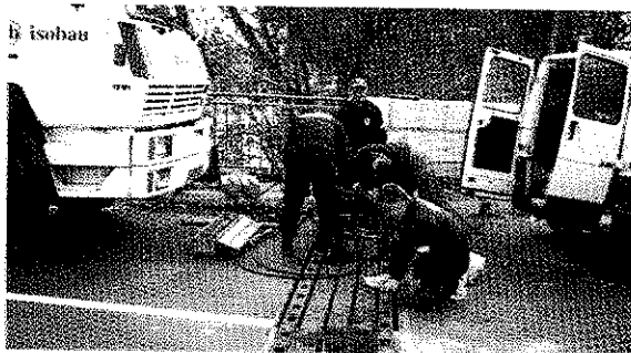
Vízzáró dilatációs szerkezet szerelése
