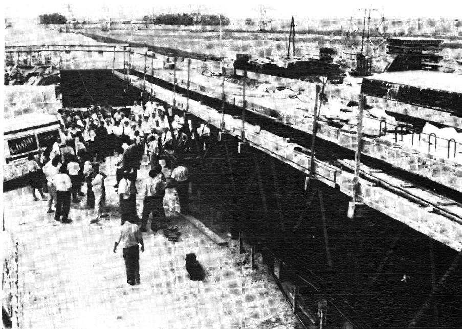
A Rába-híd szakaszos előretolt technológiával épül
